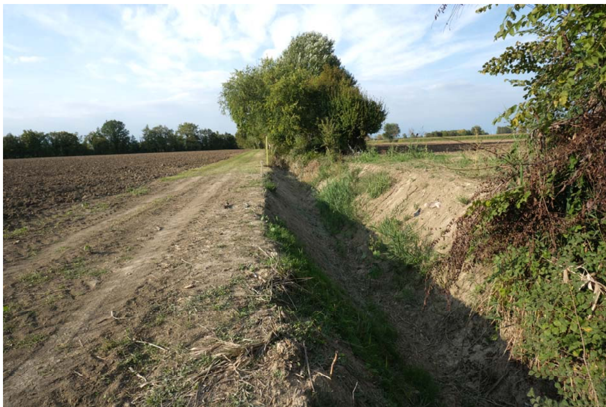
Fig. 2.3/A. Stazione FAU01, settembre 2022
