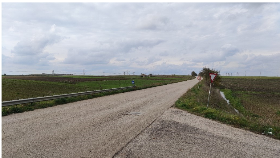
Figura 111 Foto dal punto 26 verso SE esistente
