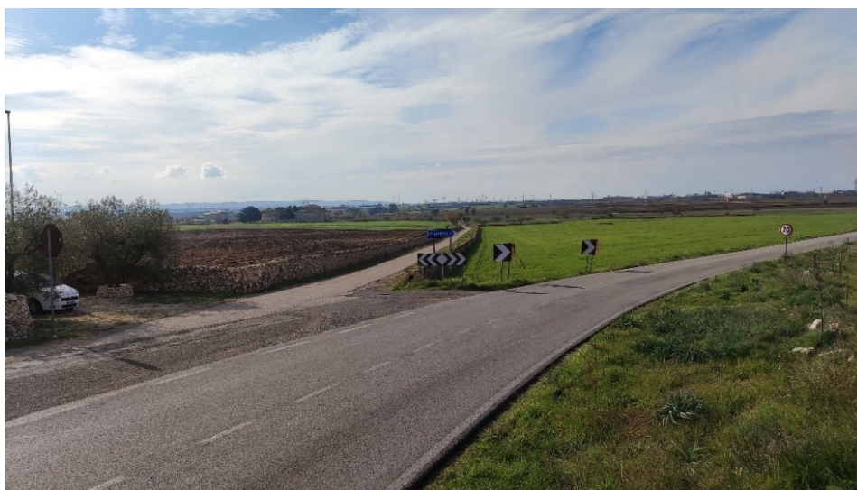
Figura 15 Foto dal punto 3 verso SE esistente
