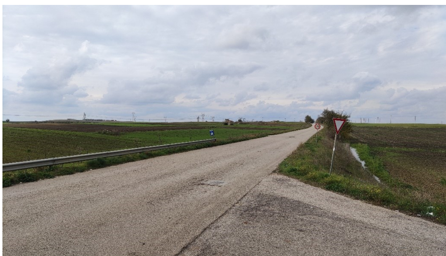
Figura 75 Foto dal punto 26 verso SE esistente
