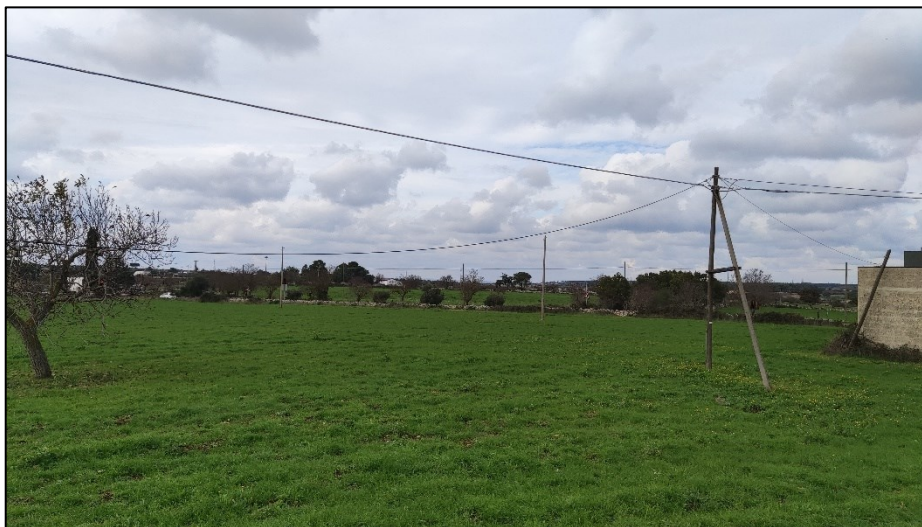
Figura 64 Foto dal punto 22 verso SE esistente
