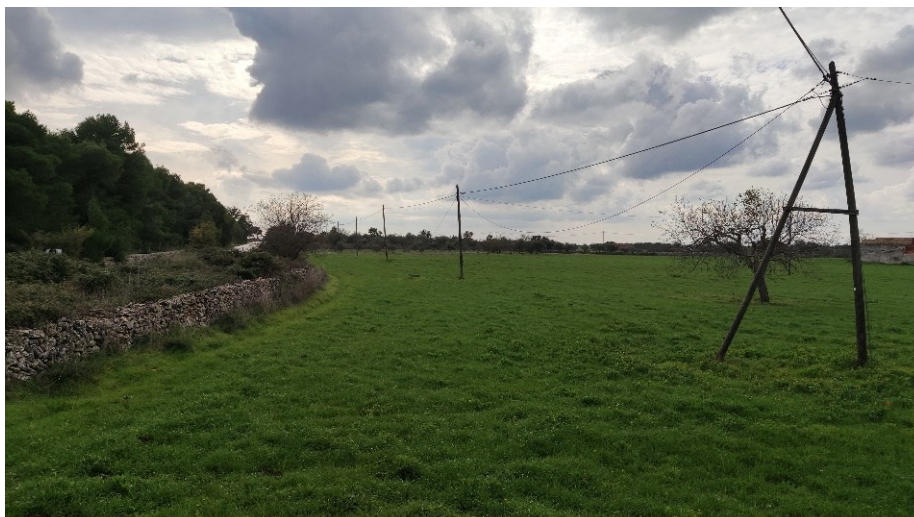
Figura 65 Foto dal punto 22 verso Impianto AGROVOLTAICO
