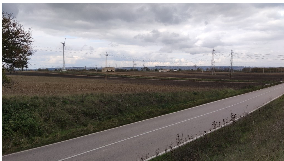
Figura 38 Foto dal punto 12 verso Impianto AGROVOLTAICO
