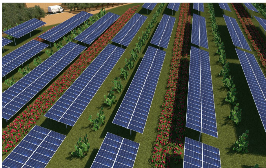
Figura 3-1 – Esempio di impianto agrivoltaico
