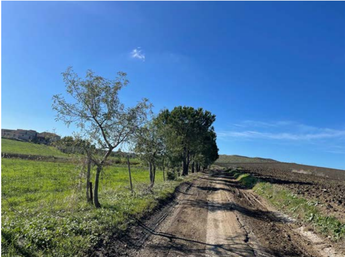
Foto 33 – Panoramica UR 08 (cavidotto interrato)
