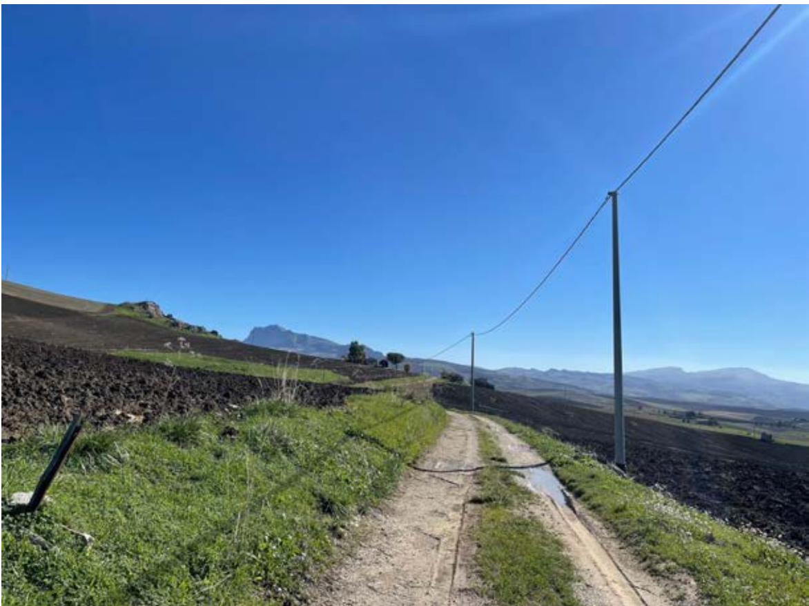
Foto 12 – Panoramica UR 03 (cavidotto interrato)
