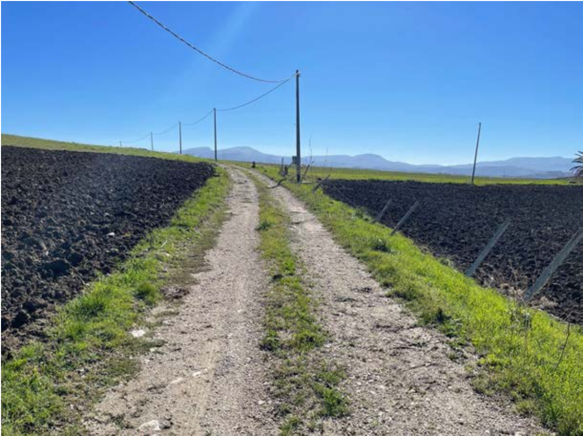
Foto 13 – Panoramica UR 02 (cavidotto interrato)
