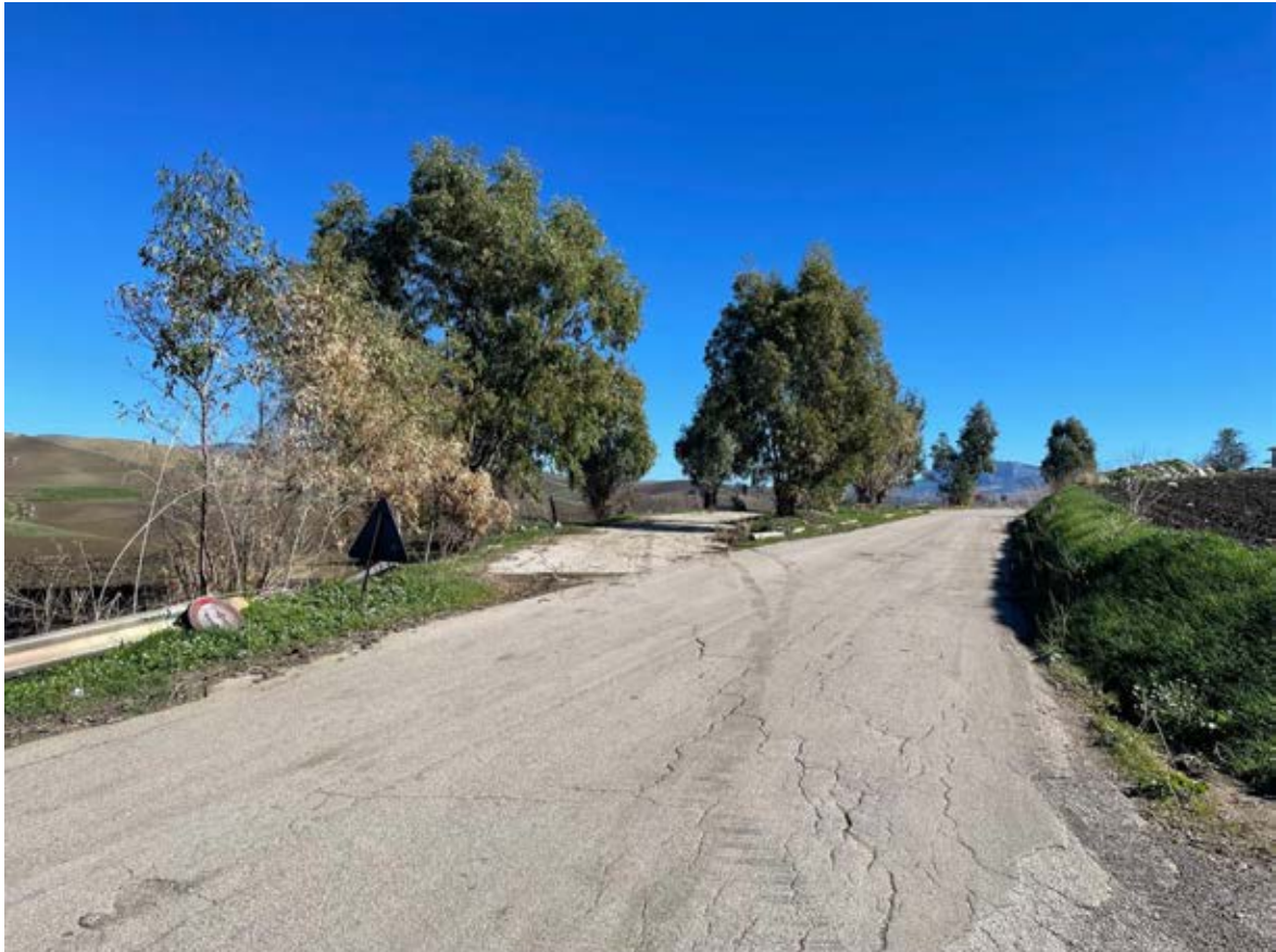
Foto 17 – Panoramica UR 05 (cavidotto interrato)
