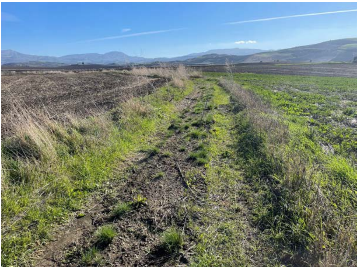
Foto 34 – Panoramica UR 08 (cavidotto interrato)
