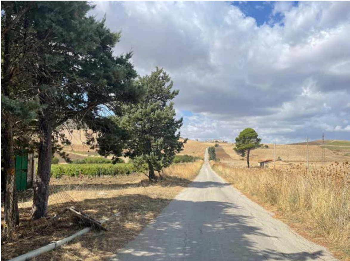
Foto 49 – Panoramica UR 11 (cavidotto interrato)
