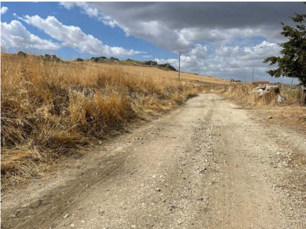
Foto 48 – Panoramica UR 11 (cavidotto interrato)
