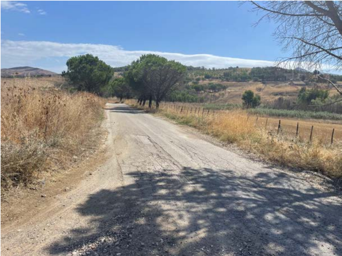
Foto 51 – Panoramica UR 12 (cavidotto interrato)
