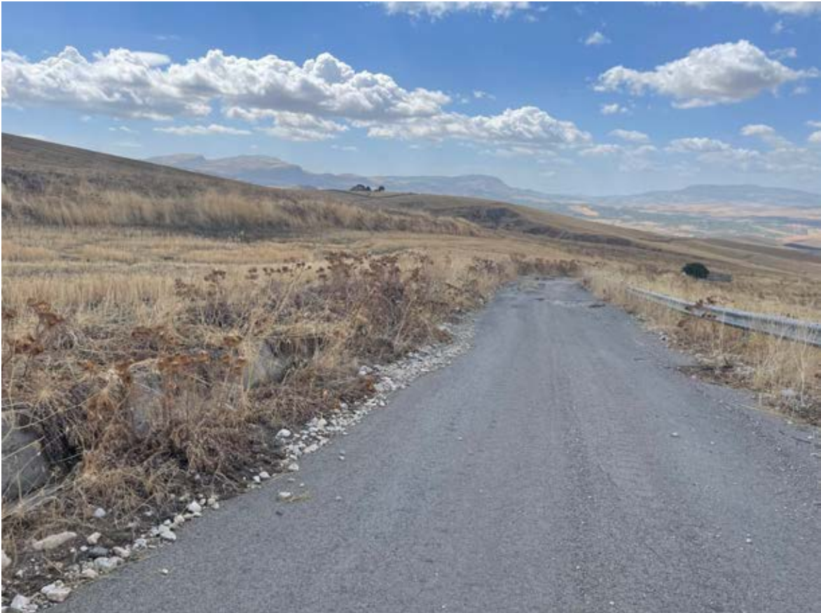
Foto 47 – Panoramica UR 11 (cavidotto interrato)
