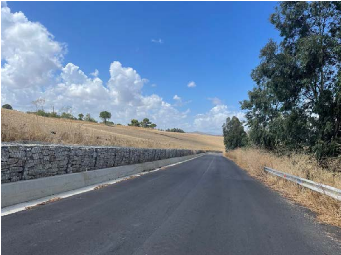
Foto 21 – Panoramica UR 05 (cavidotto interrato)
