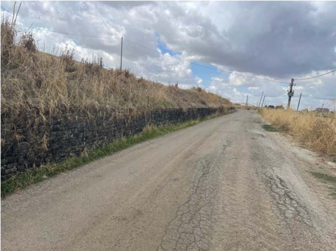
Foto 45 – Panoramica UR 11 (cavidotto interrato)
