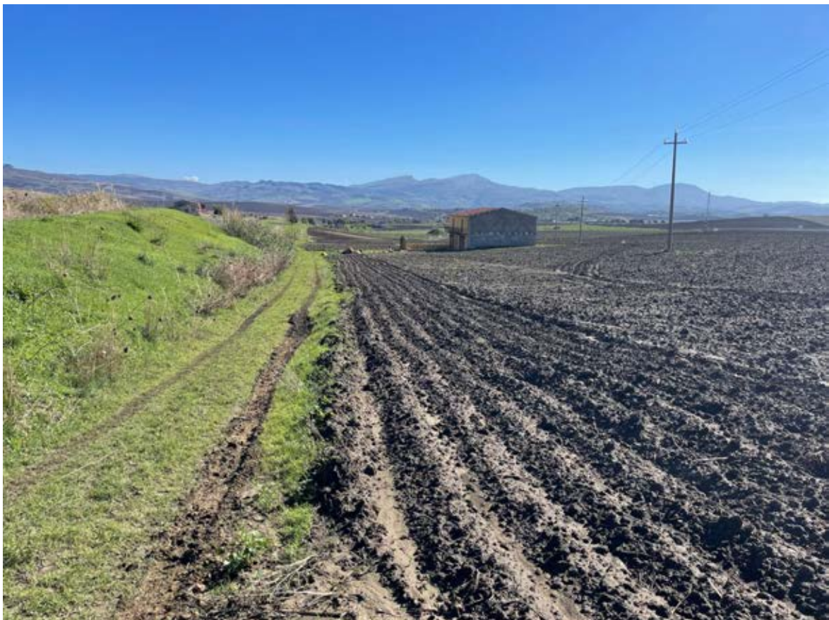
Foto 18 – Panoramica UR 06 (cavidotto interrato)
