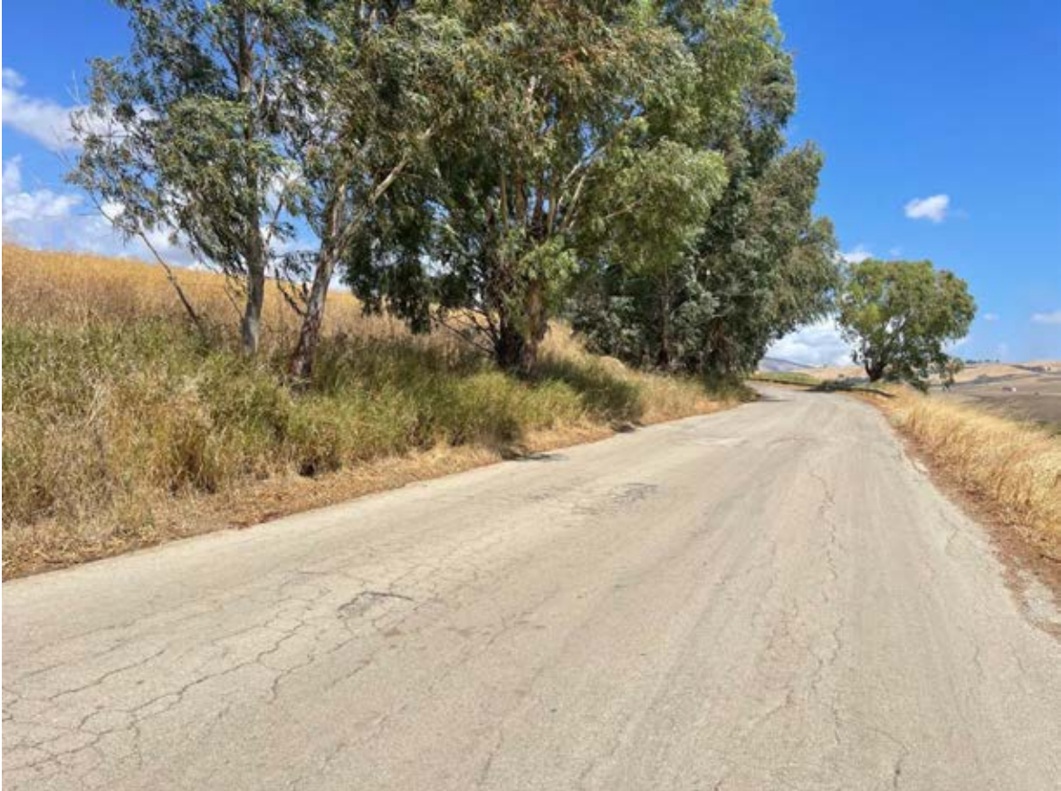
Foto 19 – Panoramica UR 05 (cavidotto interrato)
