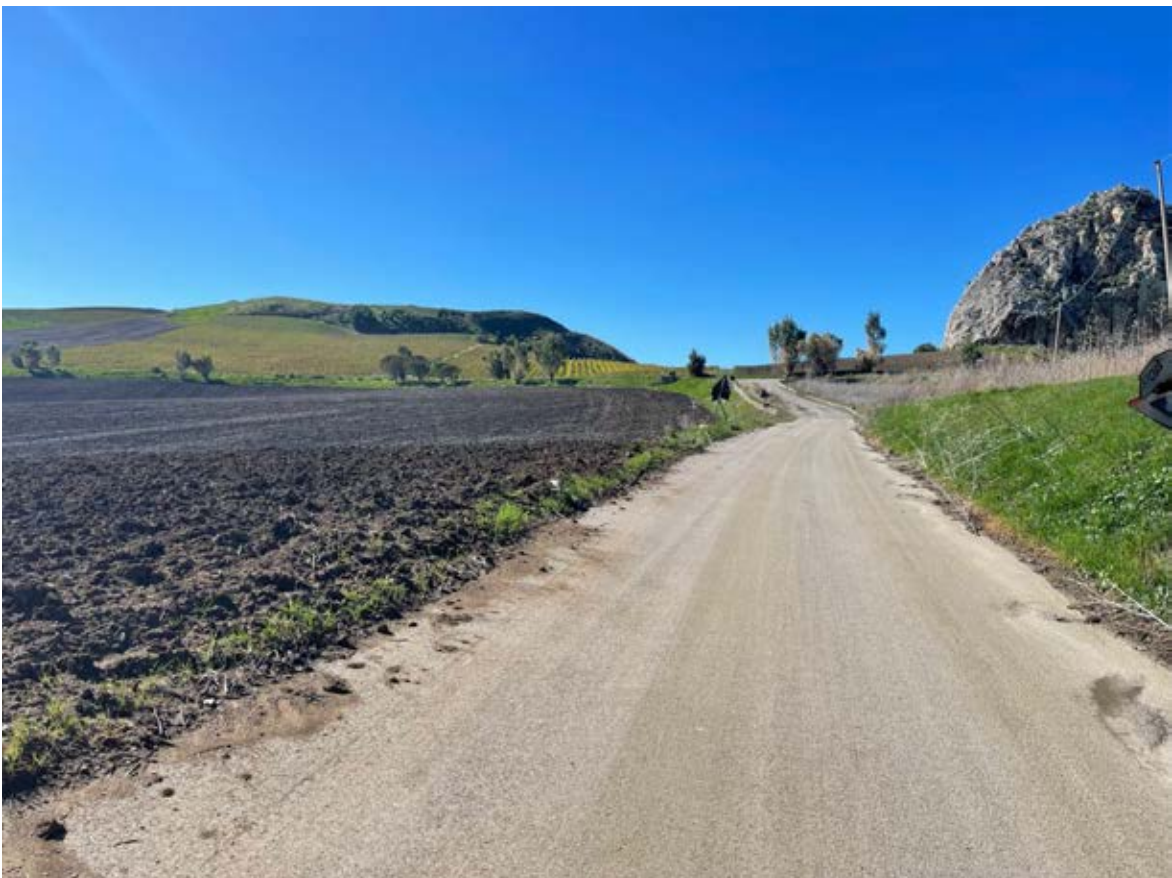
Foto 16 – Panoramica UR 05 (cavidotto interrato)
