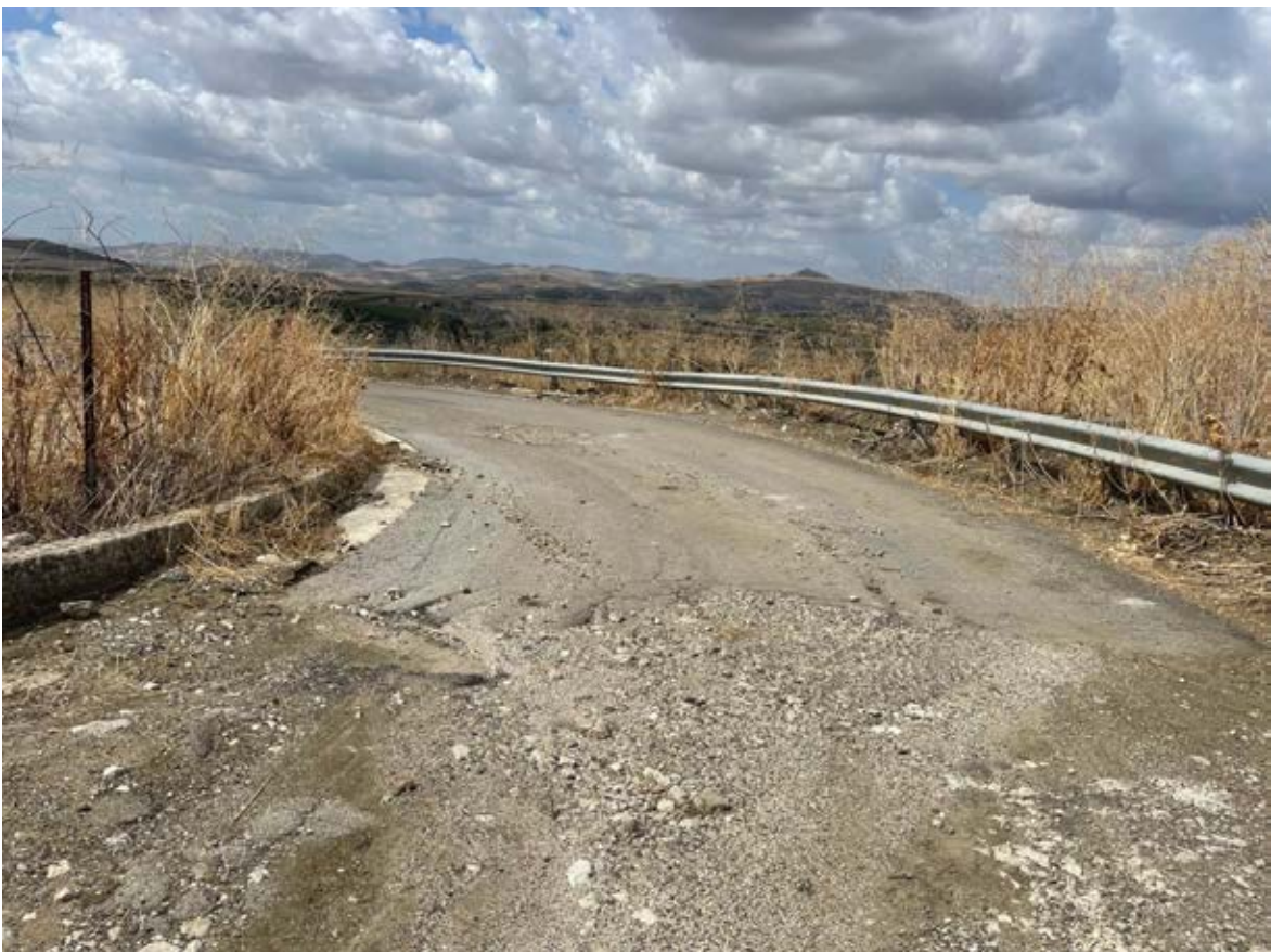
Foto 46 – Panoramica UR 11 (cavidotto interrato)
