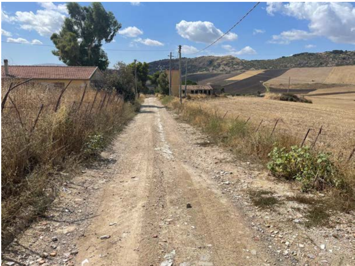
Foto 50 – Panoramica UR 12 (cavidotto interrato)
