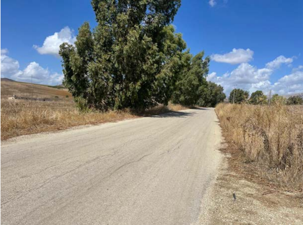
Foto 20 – Panoramica UR 05 (cavidotto interrato)
