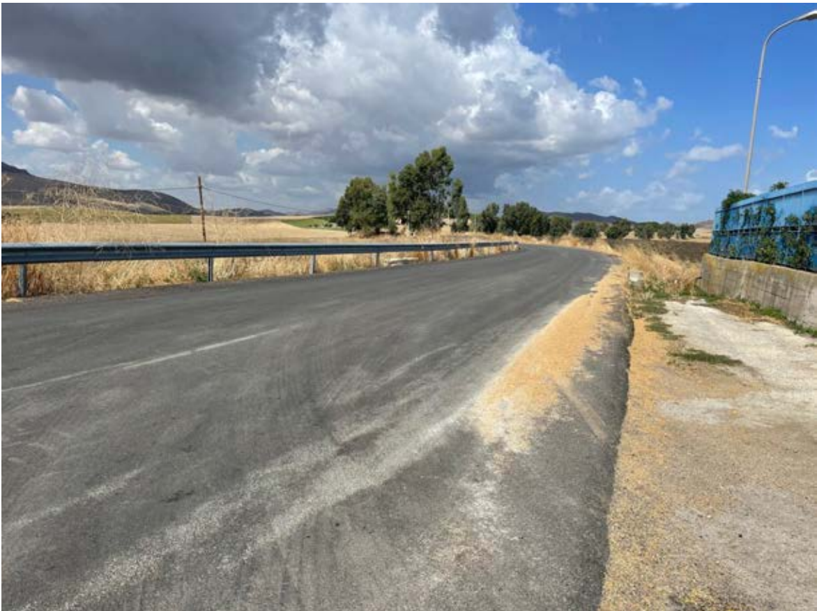
Foto 22 – Panoramica UR 05 (cavidotto interrato)
