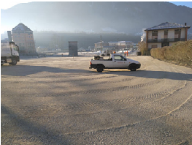
Foto 3 - in materiale drenante
