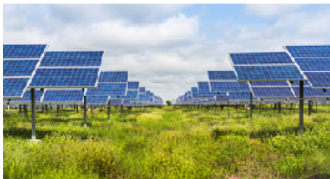
Foto 10- Impianto fotovoltaico con pannelli ad inseguimento
