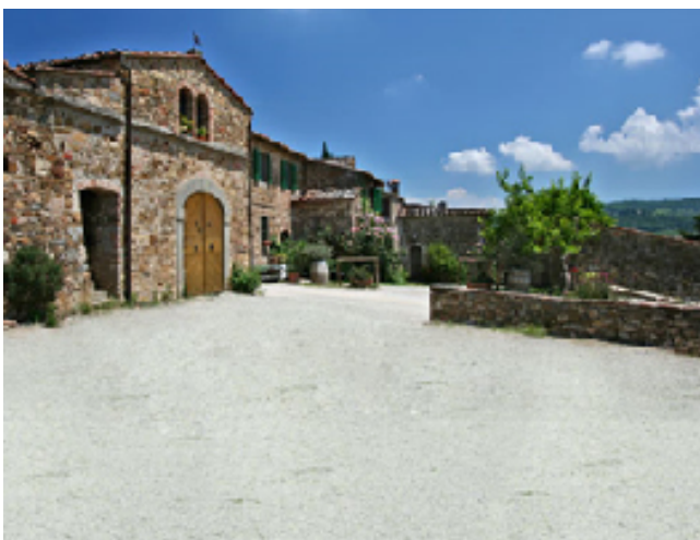
Foto 5 - in materiale stabilizzato
