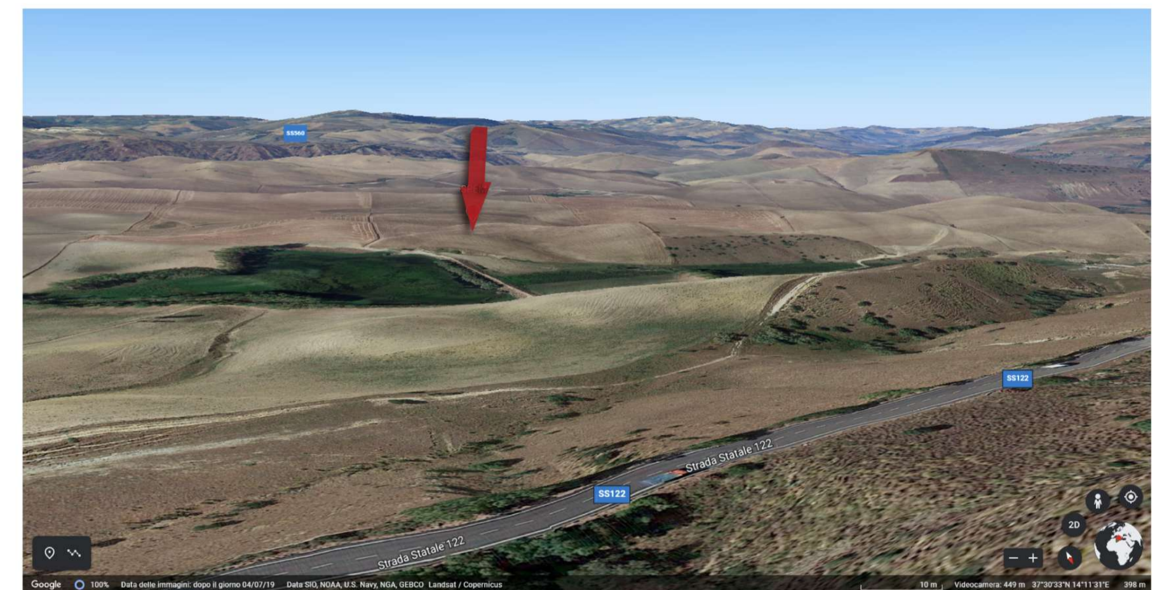
2 Google Earth - Vista sull'impianto fotovoltaico dalla strada SS122
