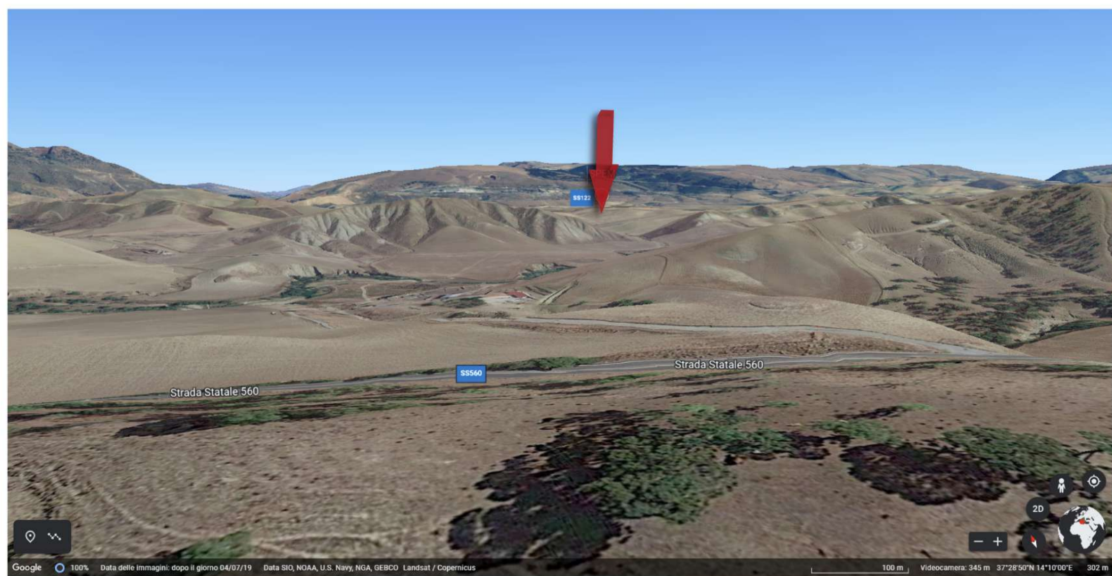
3 Google Earth - Vista sull'impianto fotovoltaico dalla strada SS560
