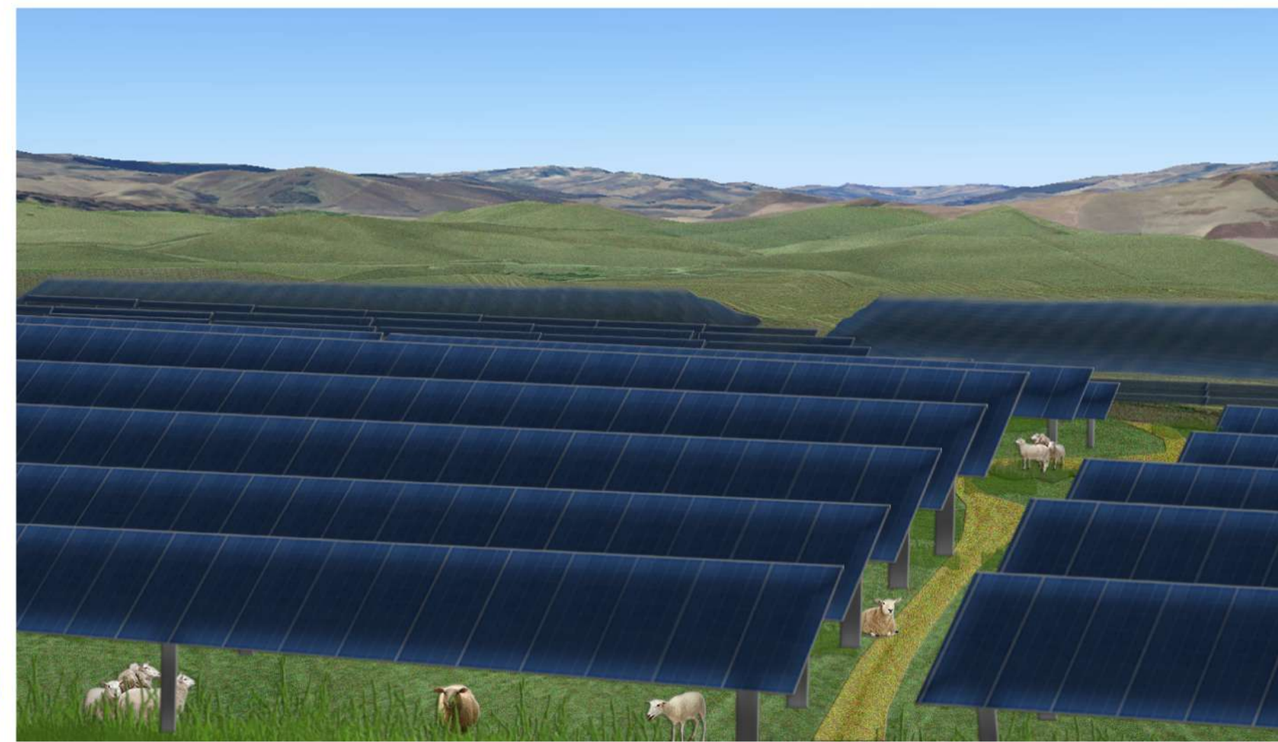
Vista dell'impianto fotovoltaico: parco agrovoltaico
