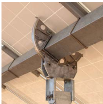
Figura 3. schema nodo trave continua / colonna
