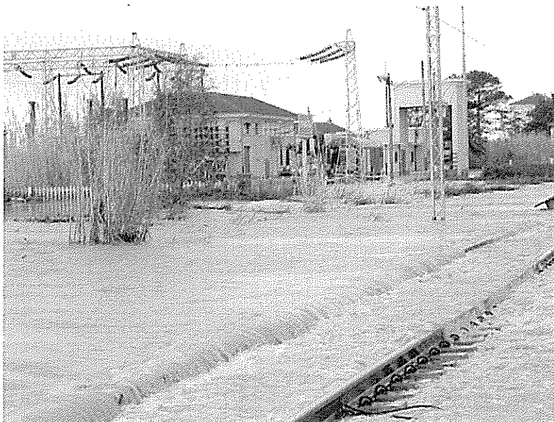
Figura 1. La ex stazione di Ripalta durante l' esondazione del Fortore. In basso a destra il binario sormontato dall'acqua
