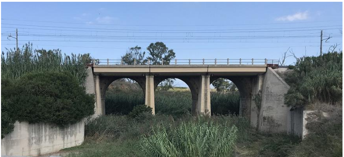
Figura – Attraversamento ferroviario esistente sul Canale Cillarese.
