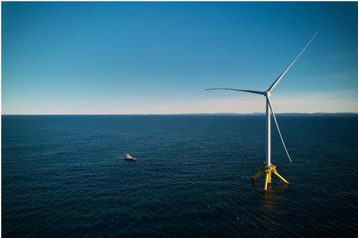
Figura 6-1: Turbina galleggiante da 3.6 MW del progetto dimostrativo TetraSpar in Norvegia, novembre 2021, di cui RWE è partner
