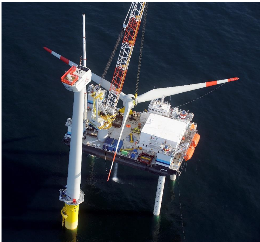
Figura 7-6: Sollevamento del rotore, impianto eolico offshore di RWE Kaskasi, Germania
