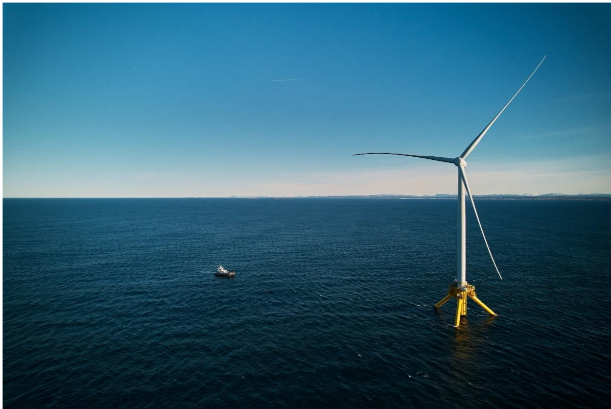
Figure 2-3: Turbina galleggiante da 3.6 MW del progetto dimostrativo TetraSpar in Norvegia, di cui RWE è partner, e relativa fondazione galleggiante del tipo spar
