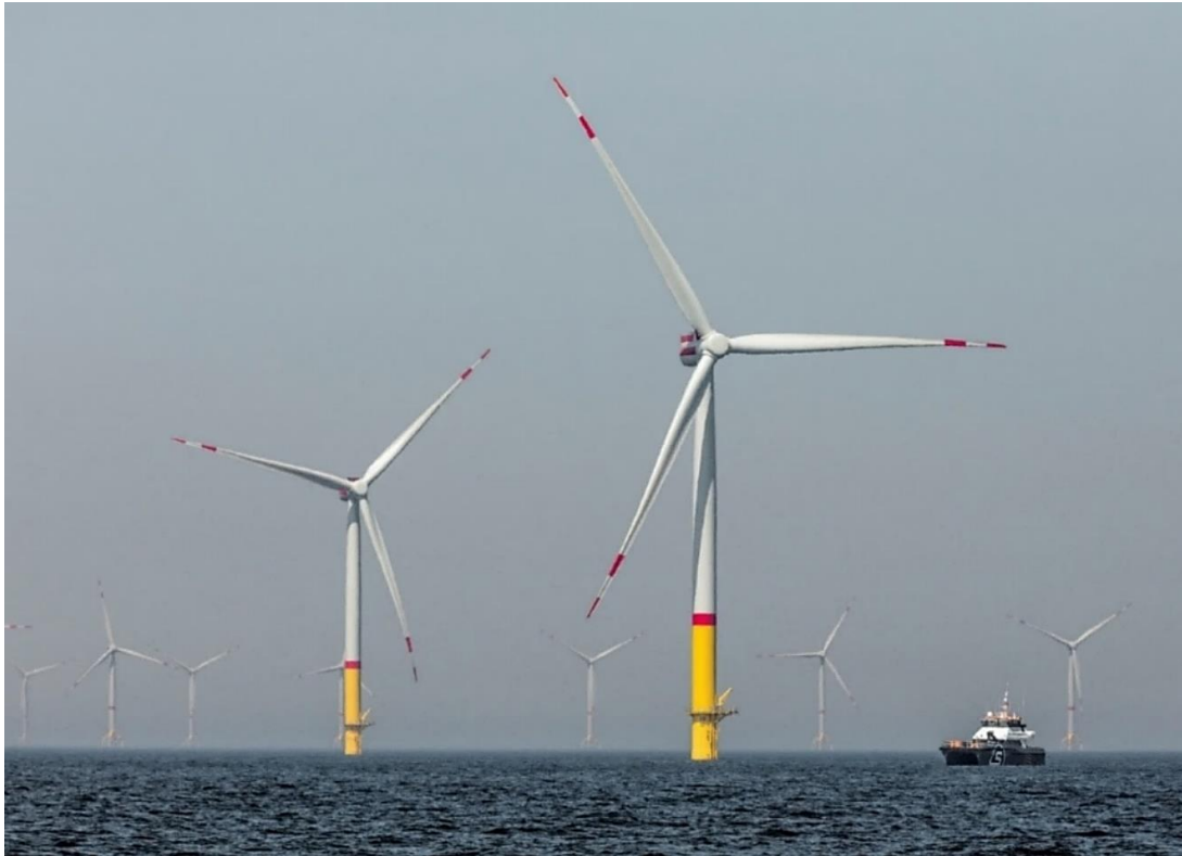
Figure 2-2: Impianto eolico offshore di RWE Arkona , Germania, da 358 MW di potenza complessiva installata
