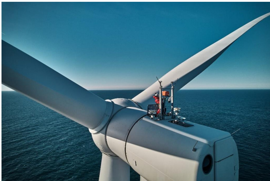
Figura 6-1: Turbina galleggiante da 3.6 MW del progetto dimostrativo TetraSpar in Norvegia, novembre 2021, di cui RWE è partner
