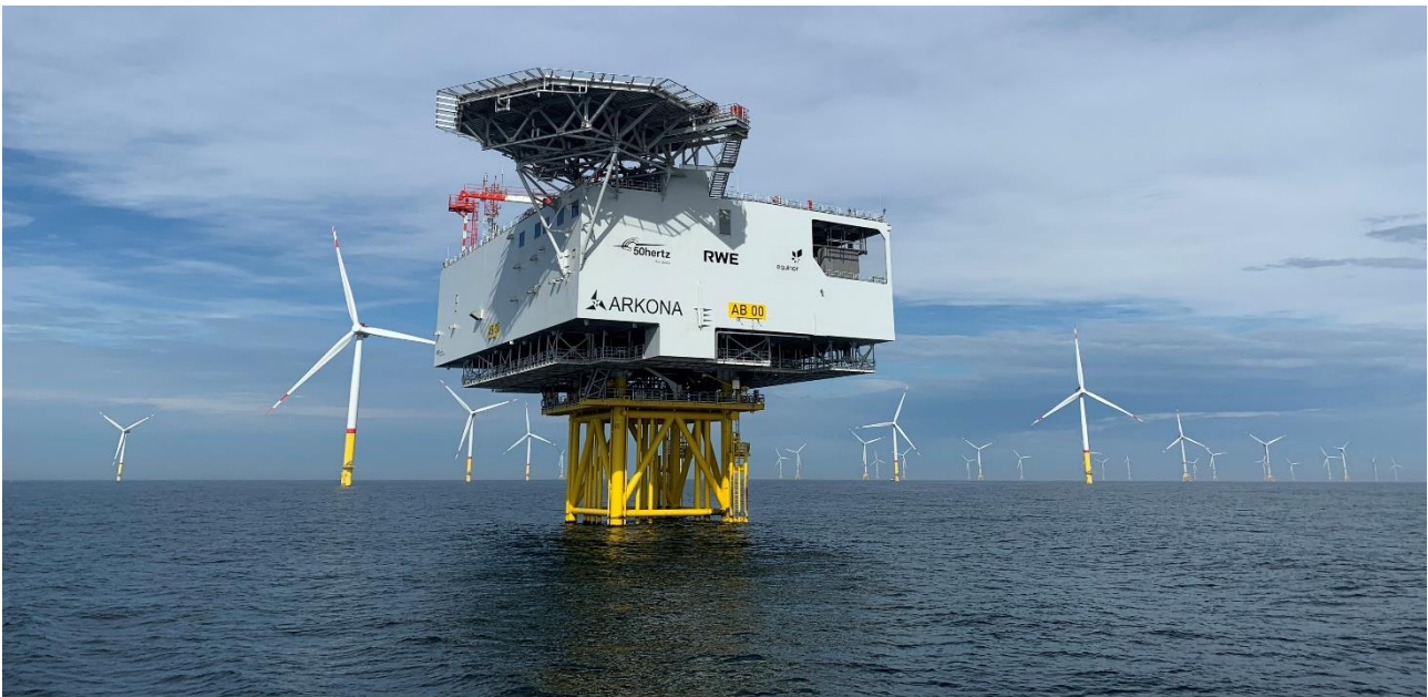
Figura 6-2: Stazione di trasformazione off-shore dell'impianto eolico RWE Arkona in Germania
