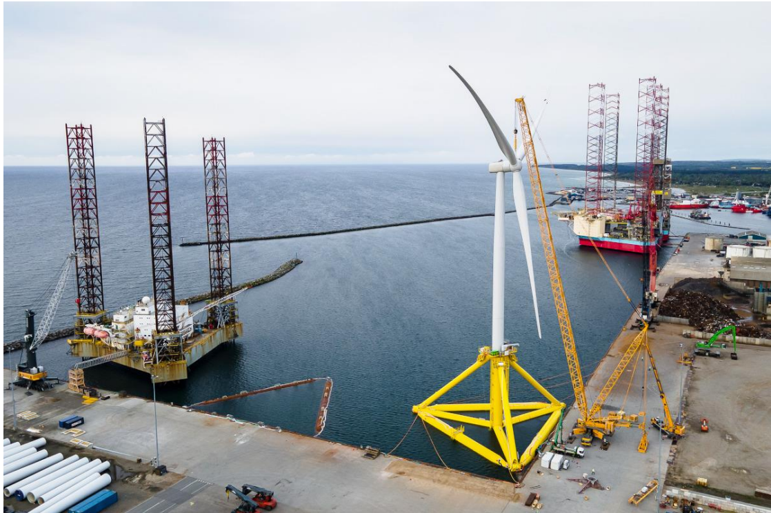
Figura 7-5: Fasi di assemblaggio della fondazione galleggiante TetraSpar
