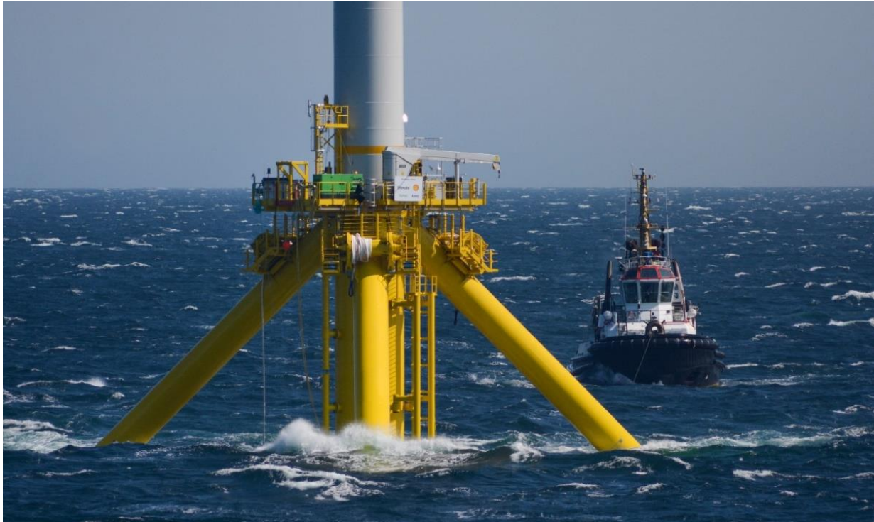
Figura 7-7: Fondazione galleggiante TetraSpar operativa, in acque di 200 m di profondità, presso il Marine Energy Test Centre, 10 km dalla costa dalla città di Karmøy in Norvegia
