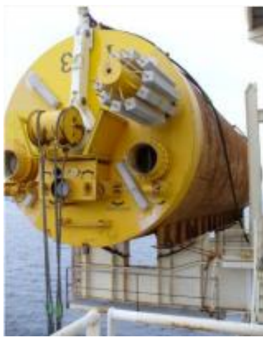
Figura 6-10: Illustrazione di palo infisso per aspirazione
