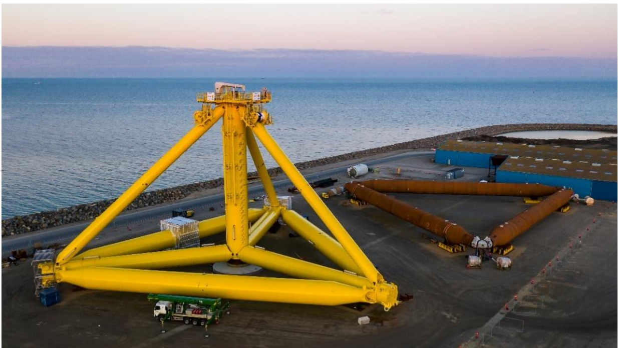
Figure 6-3: Assemblaggio nel porto di Grenaa, Danimarca della fondazione galleggiante del progetto dimostrativo TetraSpar , di cui RWE è partner, novembre 2021
