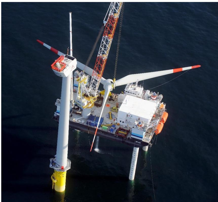
Figura 2-28: Sollevamento del rotore, impianto eolico offshore di RWE Kaskasi, Germania
