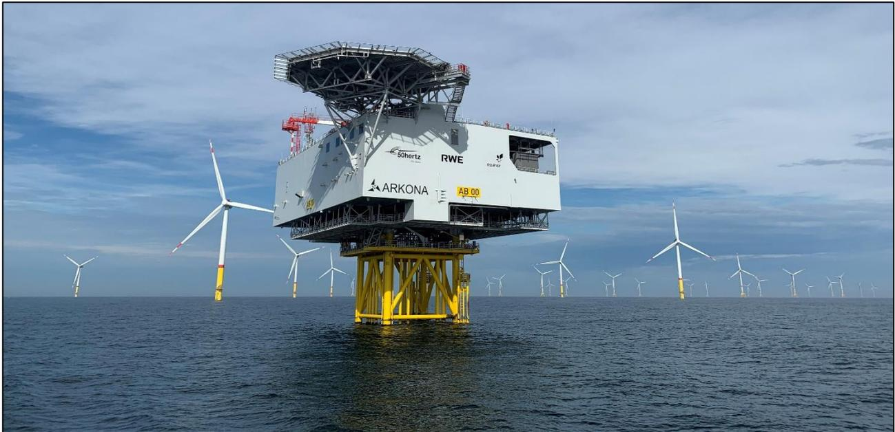
Figura 2-2: Stazione di trasformazione offshore dell'impianto eolico RWE Arkona in Germania
