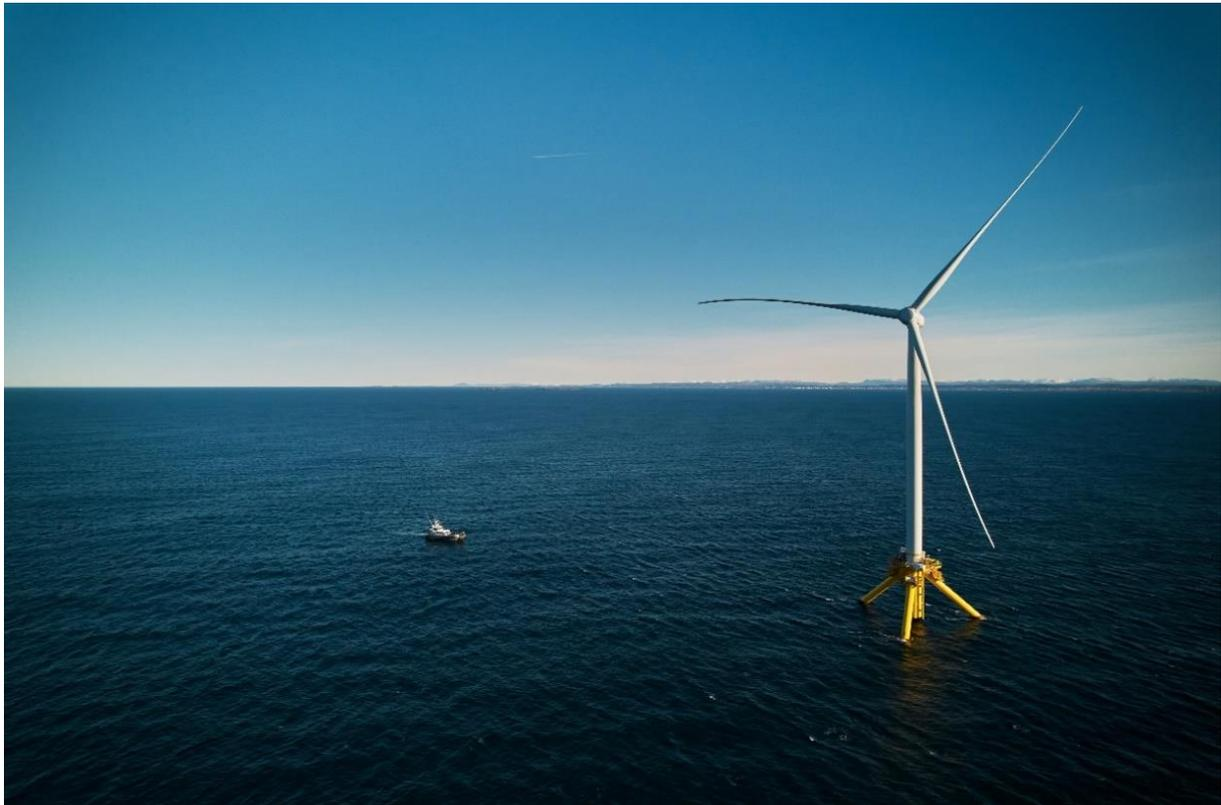
Figura 2-1: Turbina galleggiante da 3.6 MW del progetto dimostrativo *TetraSpar* in Norvegia, novembre 2021, di cui RWE è partner
