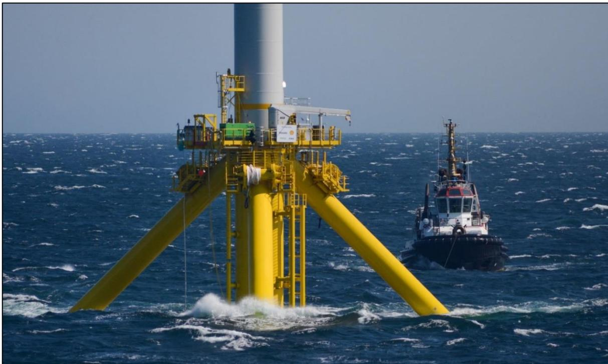
Figura 2-29: Fondazione galleggiante *TetraSpar* operativa, in acque di 200 m di profondità, presso il Marine Energy Test Centre, 10 km dalla costa dalla città di Karmøy in Norvegia
