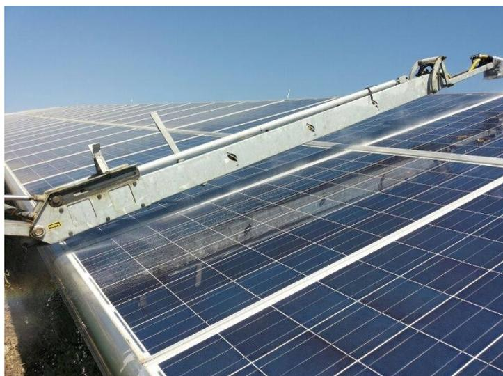
*Figura 15 – Operazioni di pulizia moduli effettuate con sistema atomizzatore con uso esclusivo di acqua.*
