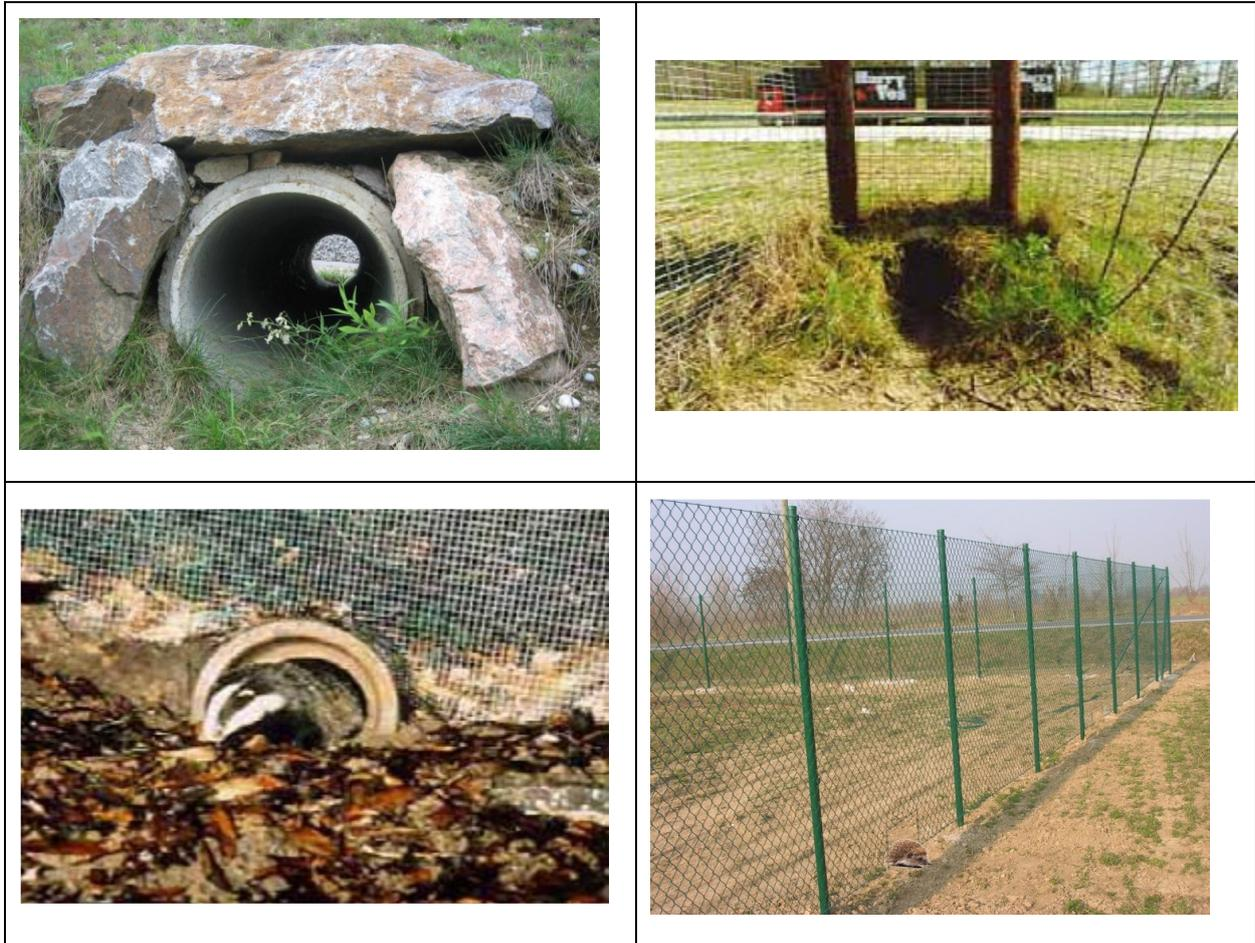
*Figura 8 - Esempi di tipologie di sottopassi per la fauna che saranno realizzati*
