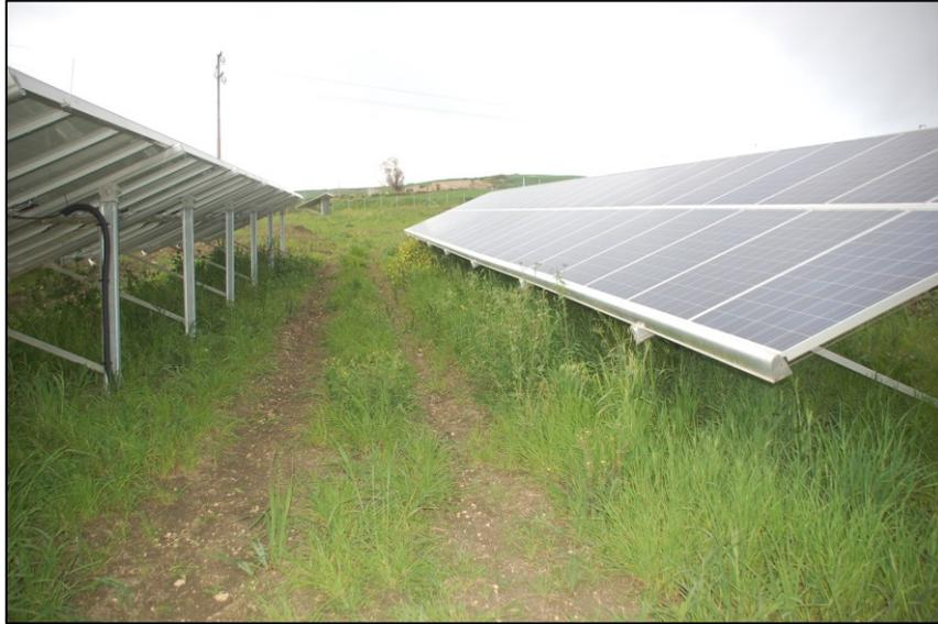
Figura 20 – Esempio impianto fotovoltaico con sistema fisso
