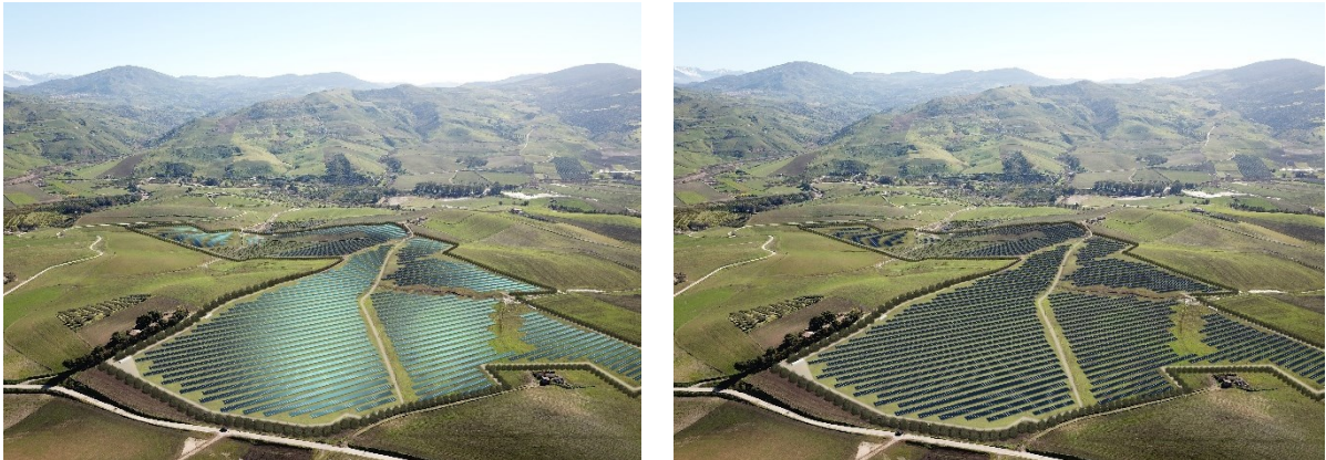
Figura 32 - Rendering dell'impianto “SERPENTANA” con moduli in silicio policristallino (foto a sinistra) e impianto con moduli con tecnologia antiriflesso in silicio monocristallino che saranno installati (foto a destra), in alto sottocampo 1, in basso sottocampi 2-3
