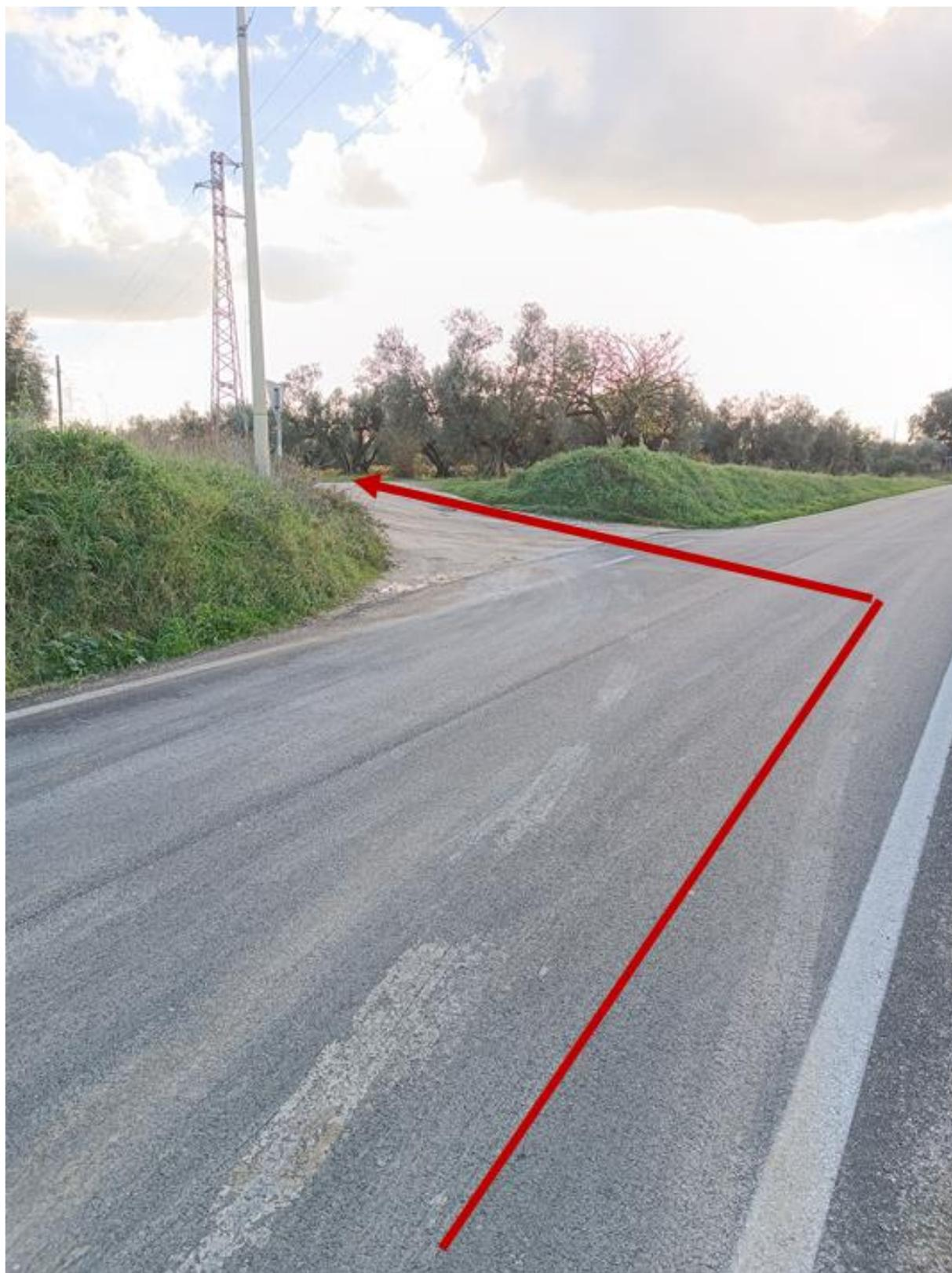
Prima dell'intersezione con la strada vicinale, verrà eseguito un nuovo attraversamento con un tratto di metanodotto in tubo incamiciato posto alla quota di -2,5 m rispetto alla sede stradale: la quota di interramento dell'elettrodotto, pari a 90 cm, come visibile in tavola IT-2021-0243\_PD\_TAV07\_Planimetria cabinati e quadri e sezione posa cavo, permette di rispettare la distanza minima di 50 cm con il sottoservizio in oggetto.
