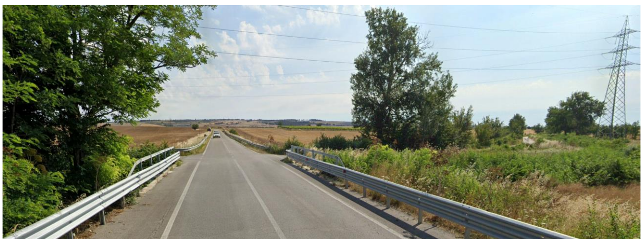
Figura 33: Attraversamento corso d’acqua
