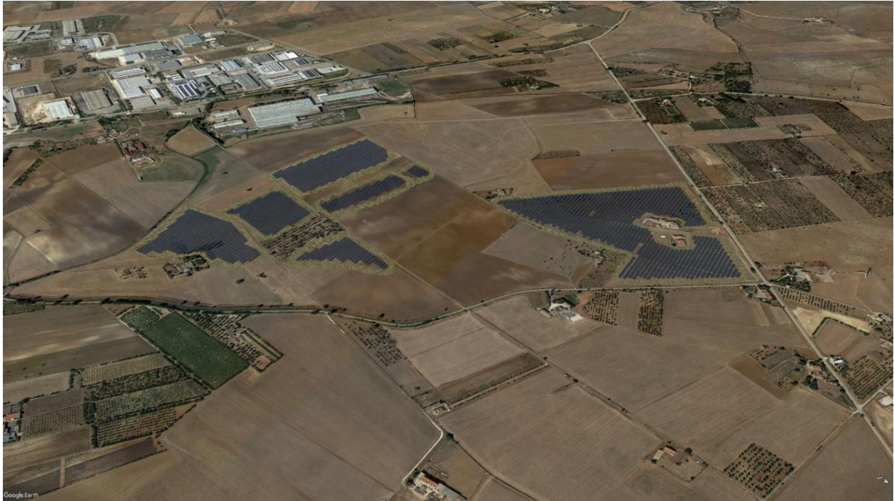
Figura 173: Vista dall'Alto Impianto Fotovoltaico con opere a verde di mitigazione sorvolo verso est
