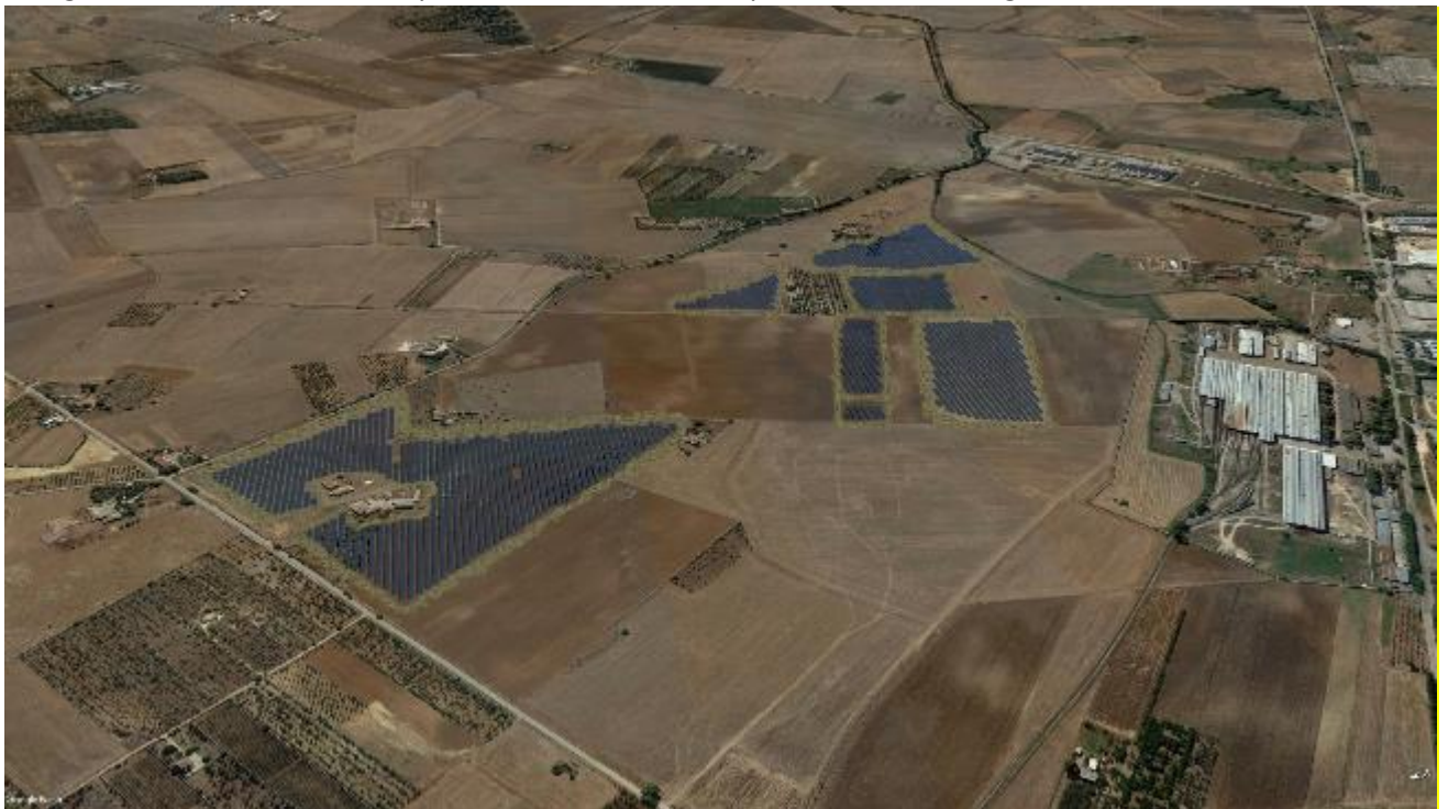
Figura 141: Vista dall'Alto Impianto Fotovoltaico con opere a verde di mitigazione sorvolo verso est
