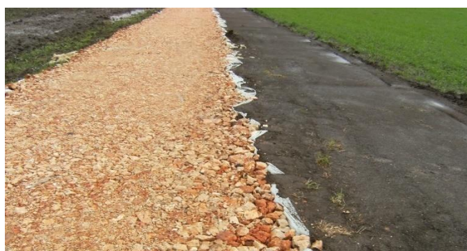
Figura 58: Esempio di strada interna al parco fotovoltaico
