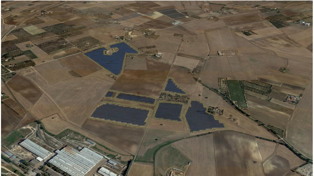
Figura 171: Vista dall'Alto Impianto Fotovoltaico con opere a verde di mitigazione sorvolo verso ovest
