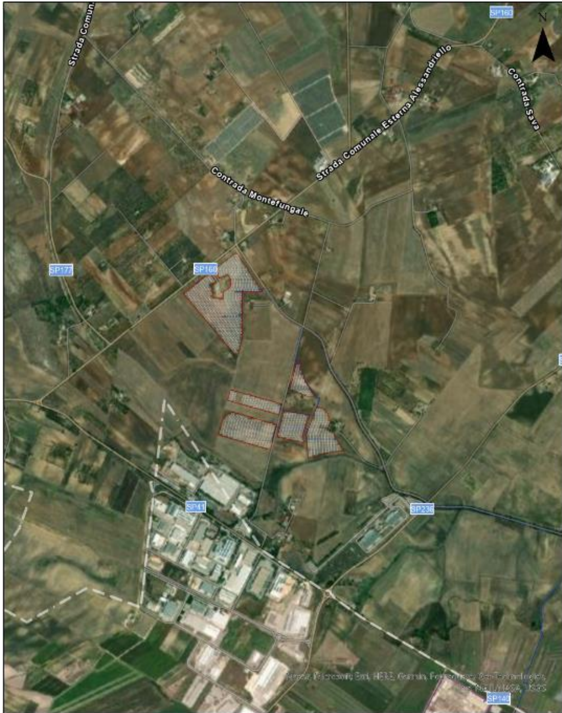
Figura 103: Viabilità di accesso all'area dell'impianto fotovoltaico.
