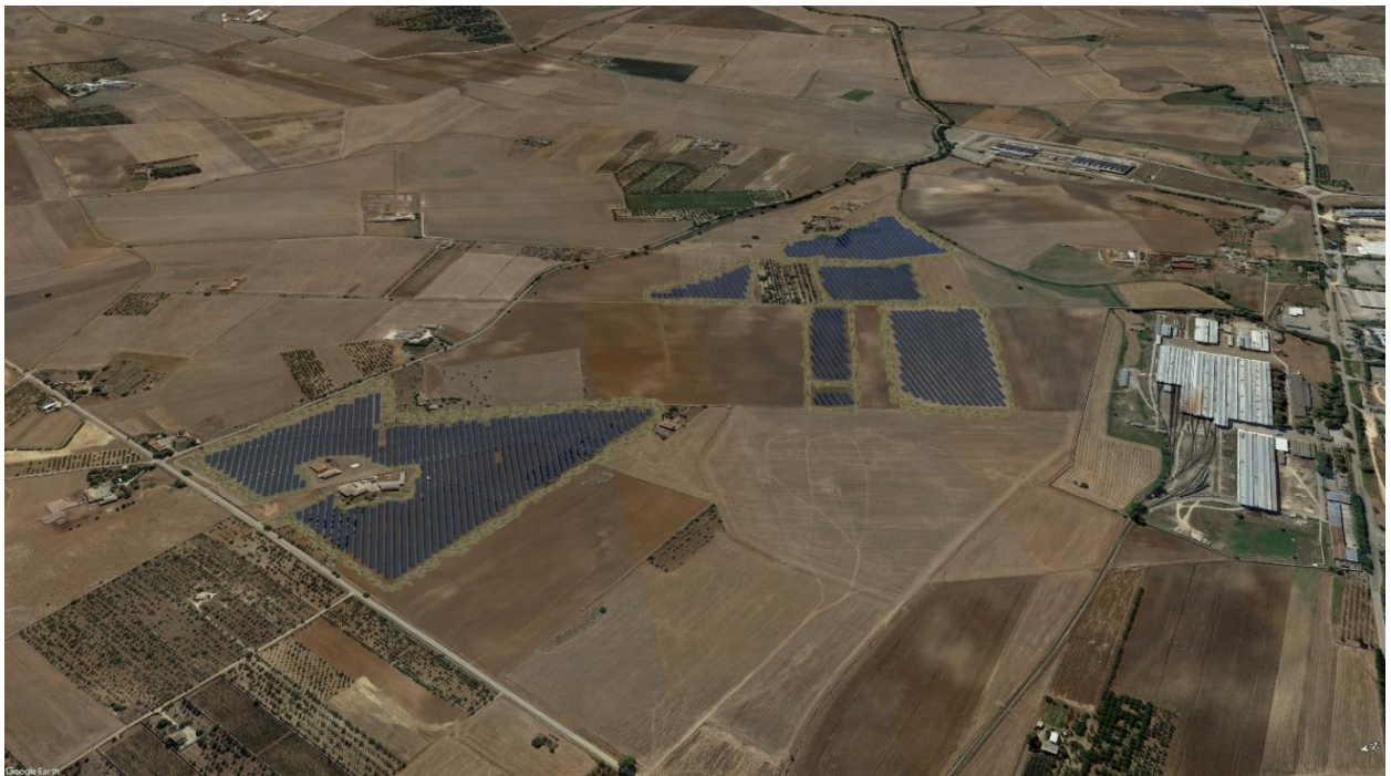
Figura 172: Vista dall'Alto Impianto Fotovoltaico con opere a verde di mitigazione sorvolo verso sud
