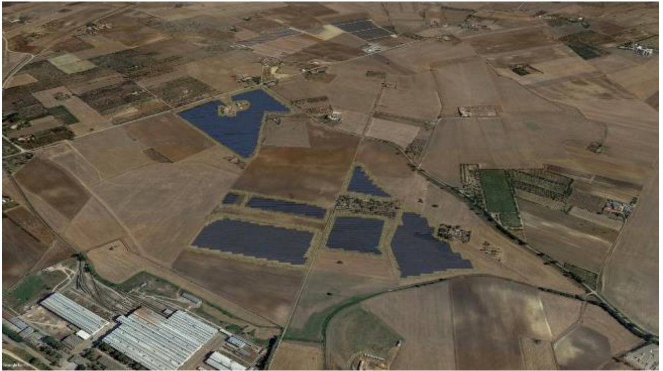
Figura 103: Vista dall'Alto Impianto Fotovoltaico con opere a verde di mitigazione sorvolo verso ovest
