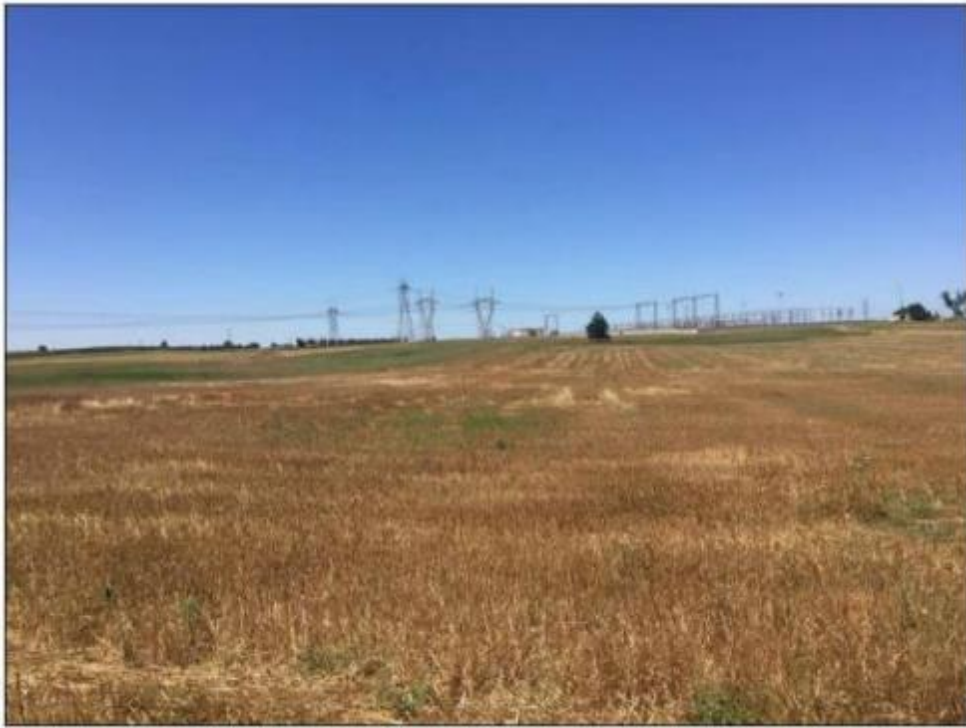
. Figura 8 : Seminativi presso la Stazione Terna
