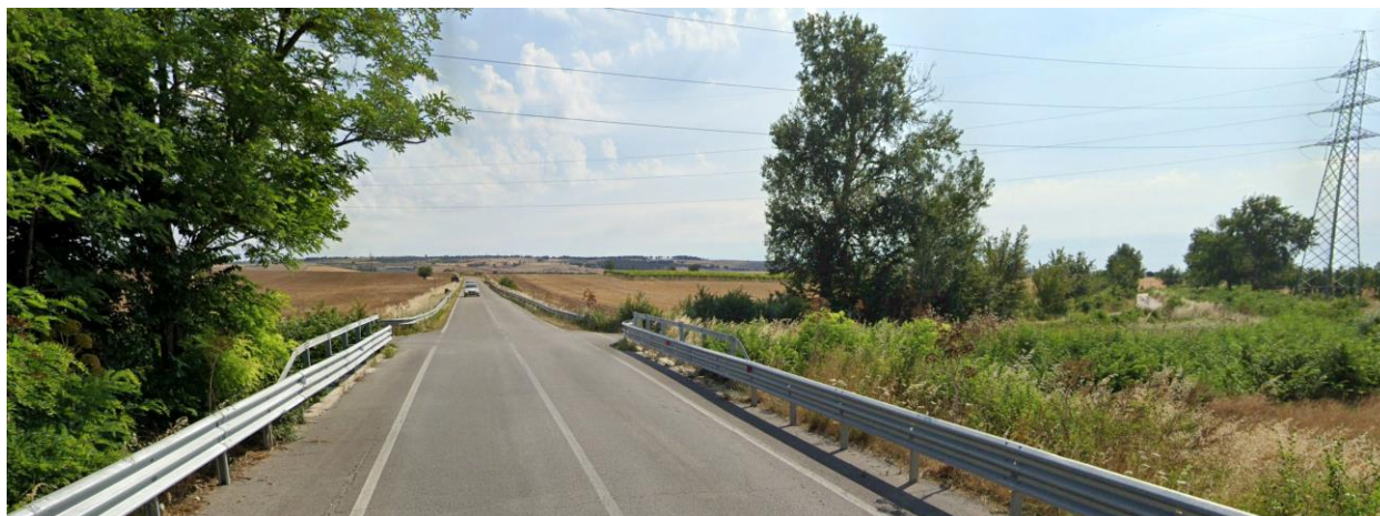
Figura 37: Attraversamento corso d'acqua
