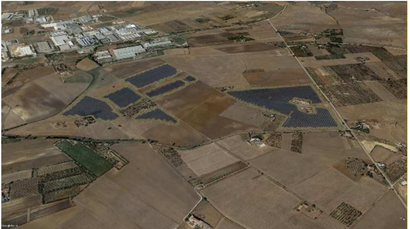
Figura 101: Vista dall'Alto Impianto Fotovoltaico con opere a verde di mitigazione sorvolo verso est
