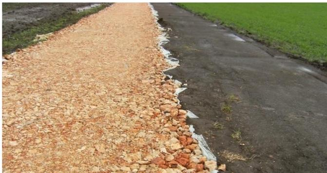
Figura 56: Esempio di strada interna al parco fotovoltaico
