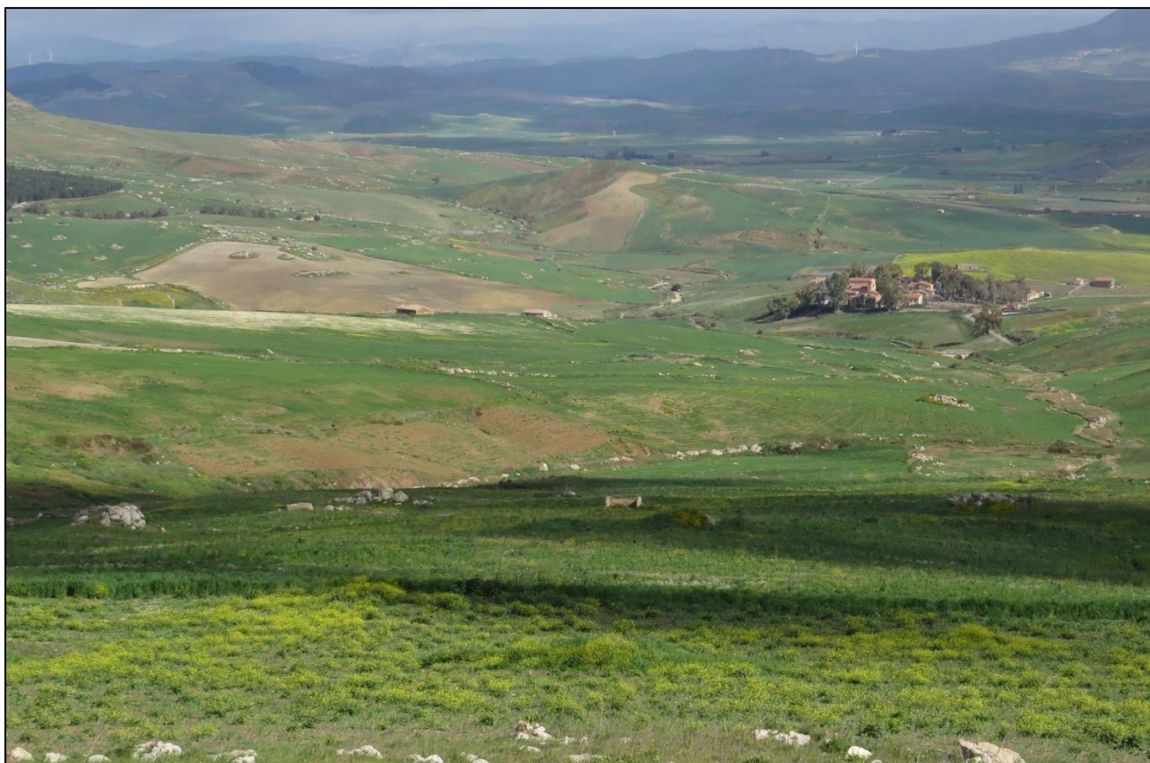
FIGURA 5 – Foto panoramica del sito di impianto
