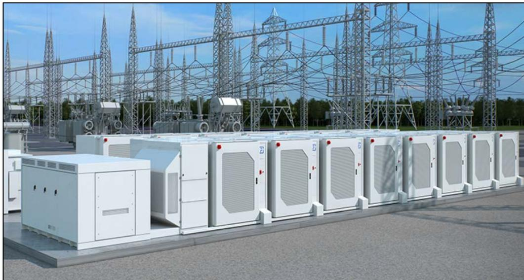
Figura 36: esempio di sistema di stoccaggio per impianto fotovoltaico - Gridstack
