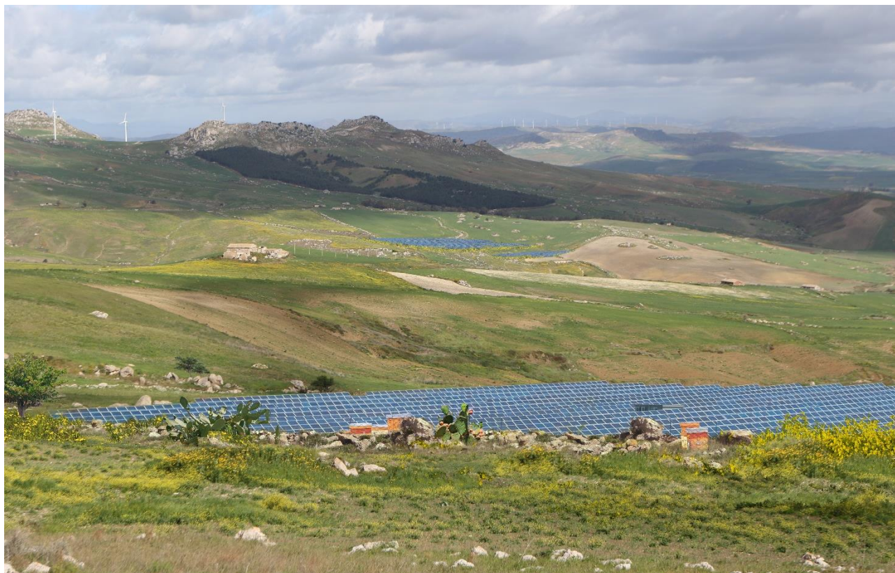
Figura 28: Foto inserimento impianto con particolare apicoltura e misure mitigazione
