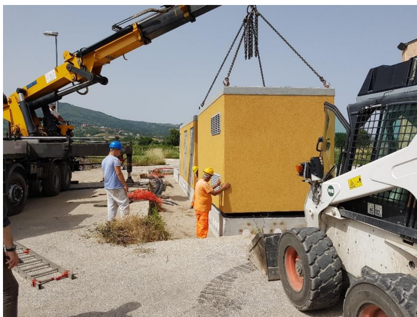
Figura 19 Esempio di posizionamento delle cabine
