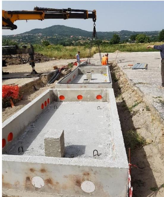
**Figura 94 Esempio di basamento delle cabine**
