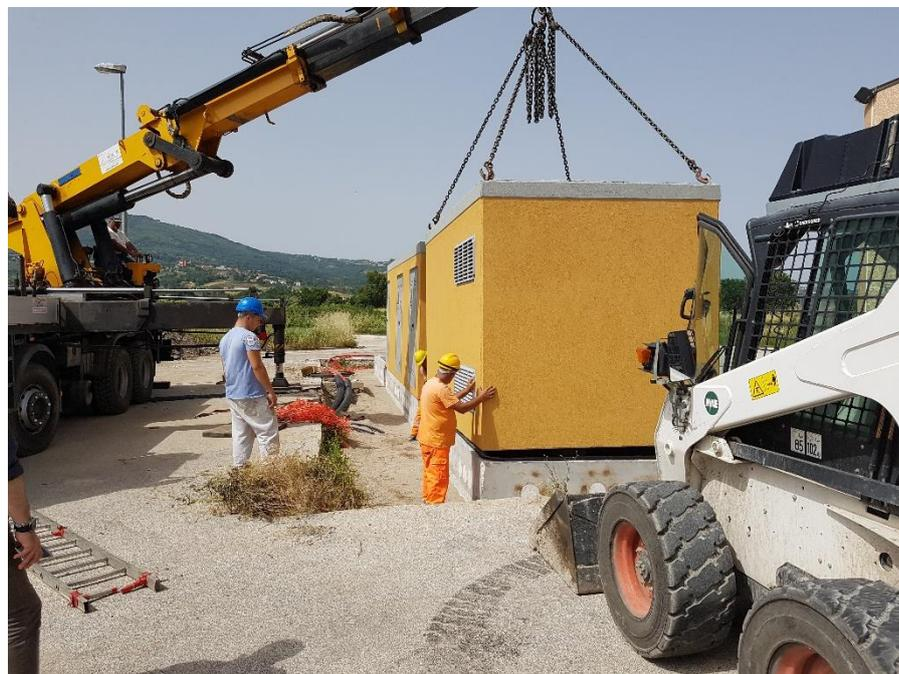
**Figura 95 Esempio di posizionamento delle cabine**
