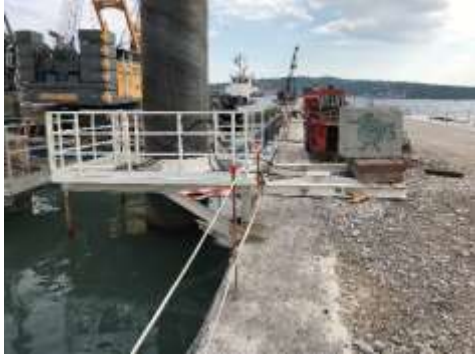
Realizzazione primo palo con dima da terra
