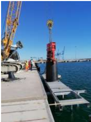
Infissione camicia palo e successivo utilizzo di perforatrice
