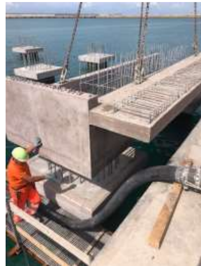
Esempio posa travi principali
