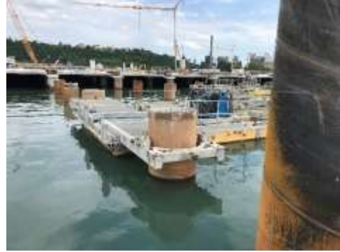
Realizzazione successivi pali con dima a mare
