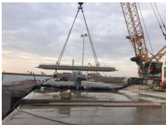
Sollevamento e posa prefabbricati
