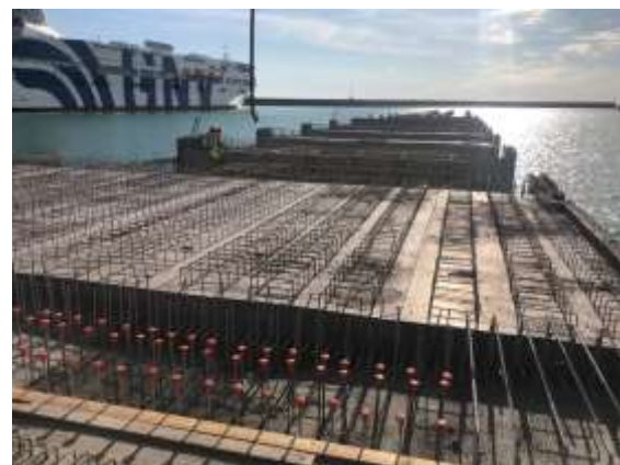
Sollevamento e posa prefabbricati
