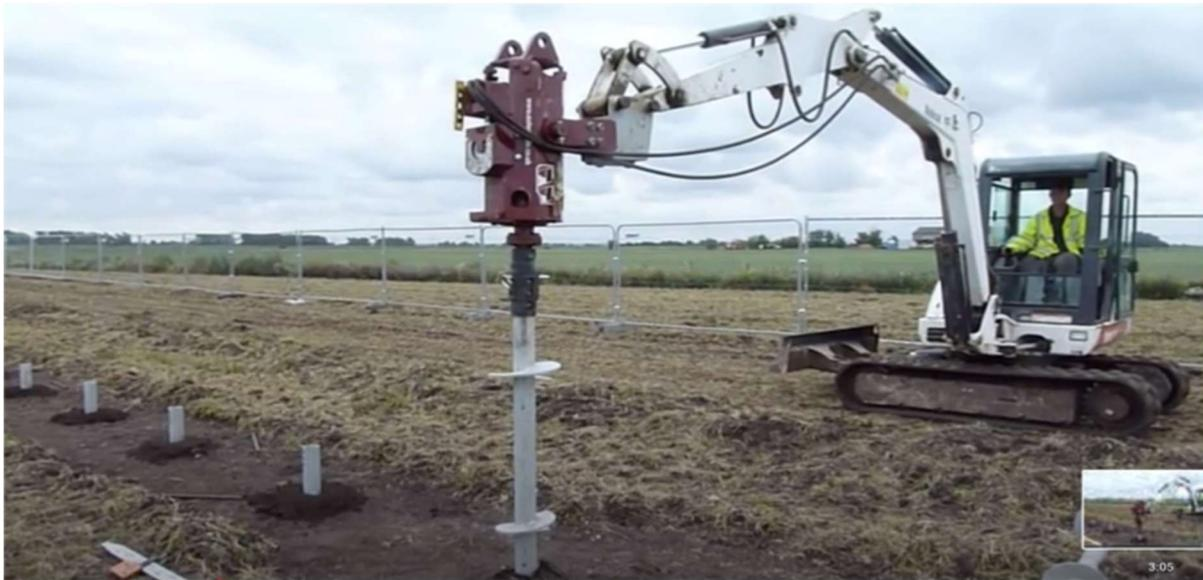
**Figura 4-3 Macchina Operatrice per fissaggio supporti strutture**
