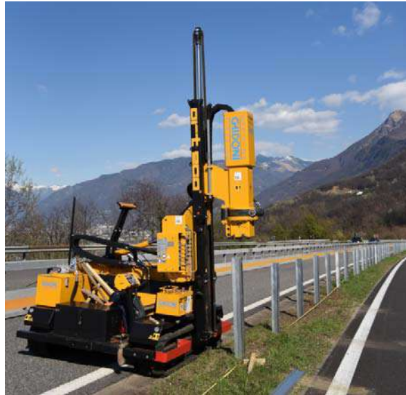
Fig.1 – Esempio di battipalo
