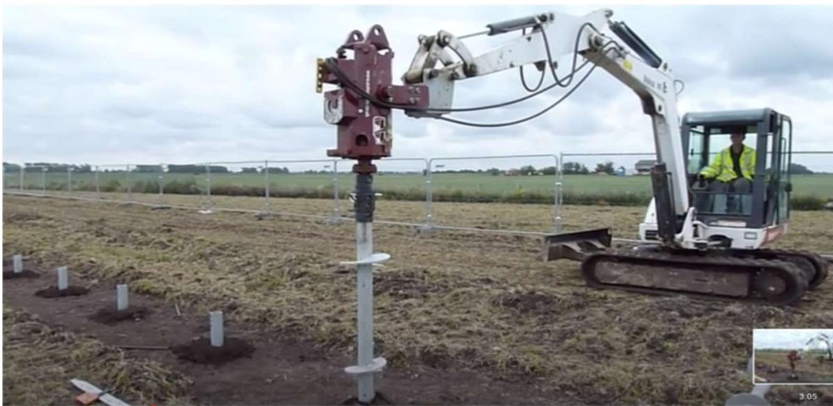
*Figura 2-5 Macchina Operatrice per fissaggio supporti strutture*
