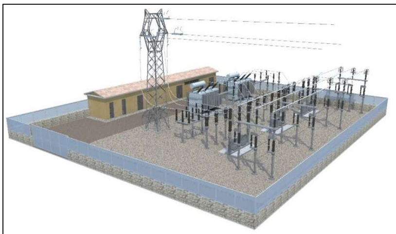
Figura 9-1 Sottostazione tipo con apparecchiatura ad alta tensione, trasformatore,
