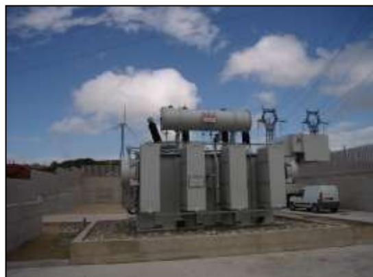
Figura 5-7 Schema trasformatore MT/AT
