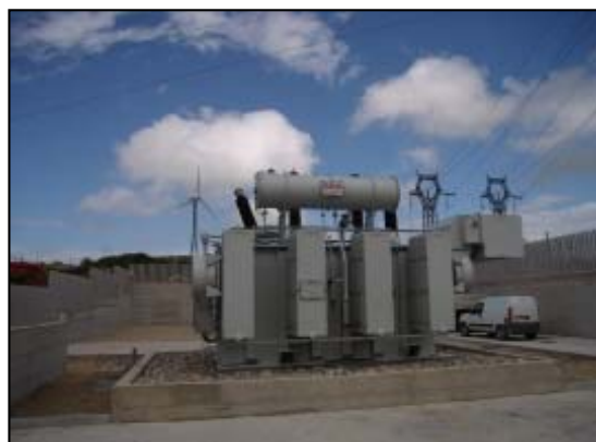
Figura 3-8 Trasformatore MT/AT
