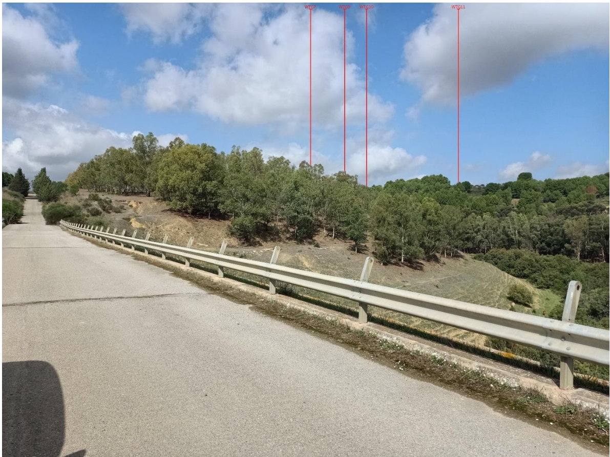
Scatto dal punto P06 (b): ante operam - post operam
