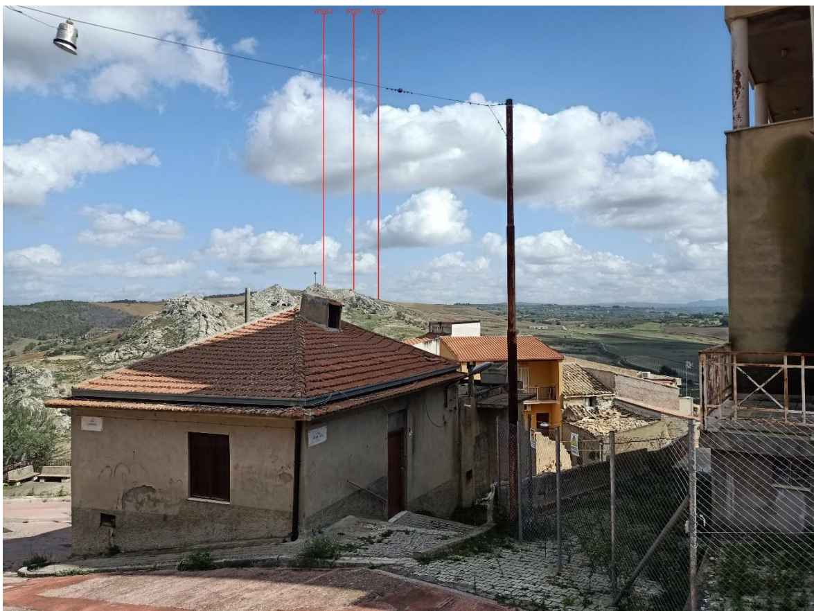
Scatto dal punto P08 (a): ante operam - post operam
