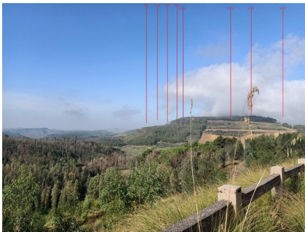
Scatto dal punto P02 (a): ante operam - post operam
