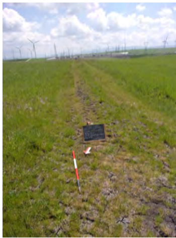
Fig. 34, cavidotto esterno con collegamento alla stazione RTN su terreno in avvicinamento alla stazione , visto da nord
