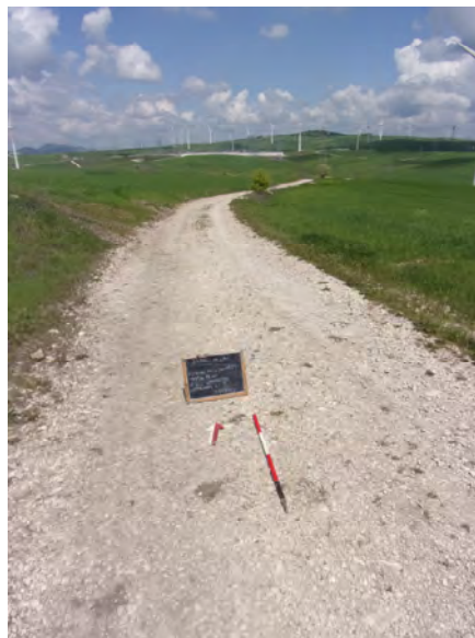
Fig. 29, cavidotto interno di collegamento tra i sottocampi 4 e 5 loc. Piano del Pero Spaccone, visto da sud
