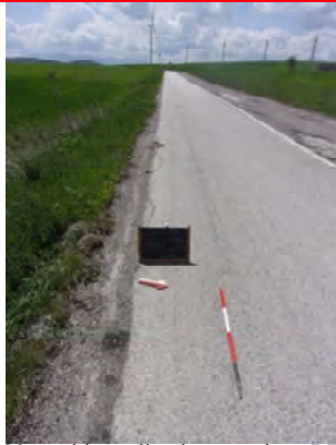
Fig. 23, cavidotto direzione stazione RTN su SS91 vista da est
