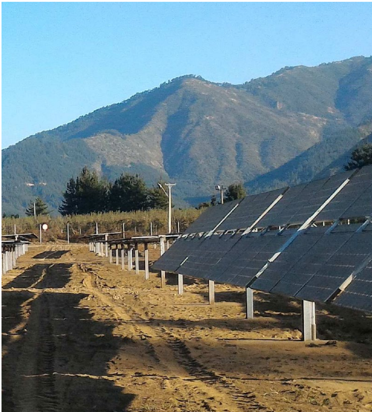
Fig. 6 Disposizione dei moduli fotovoltaici sui tracker
