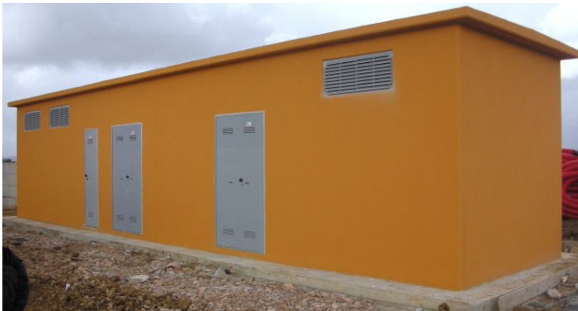
Fig.5 Posizionamento di una delle cabine elettriche
