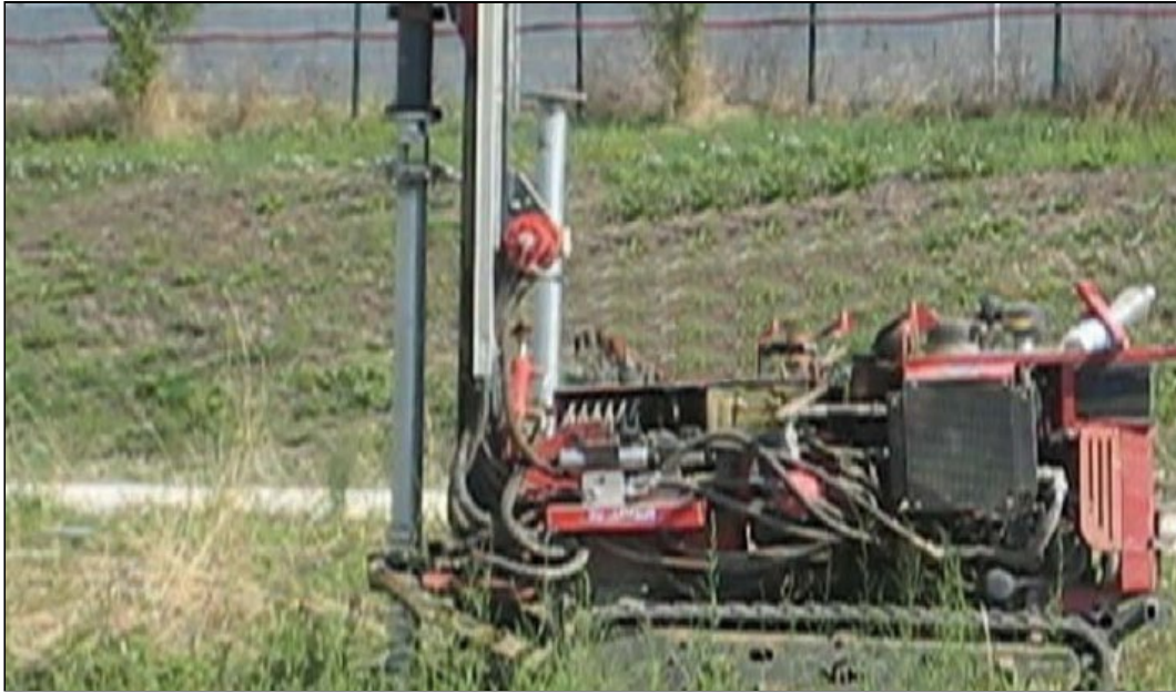
Fig. 2 inserimento pali di fondazione
