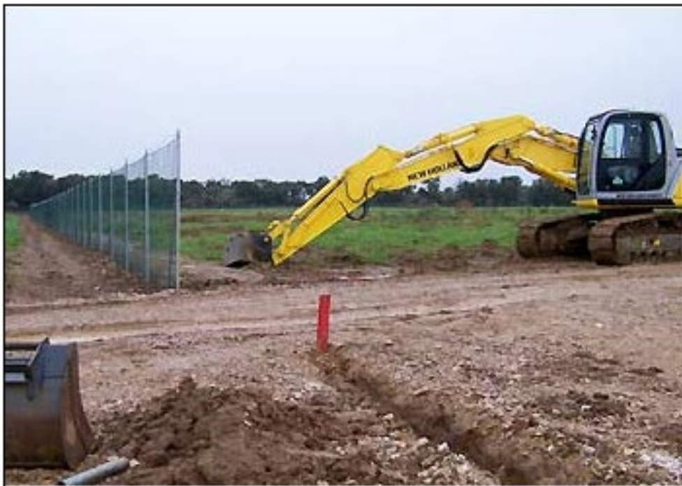
Fig. 5 Predisposizione della recinzione del parco fotovoltaico
