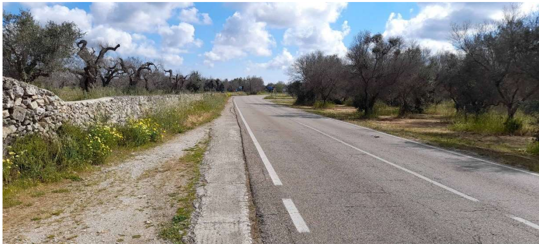
Figura 2 - vista SP147 (prossimità cabina di consegna)
