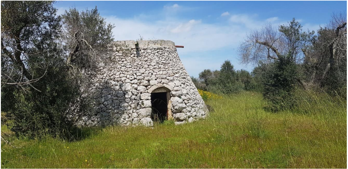
Foto 6 – Particolare della “Pagghiara” posta nell’area in oggetto.
