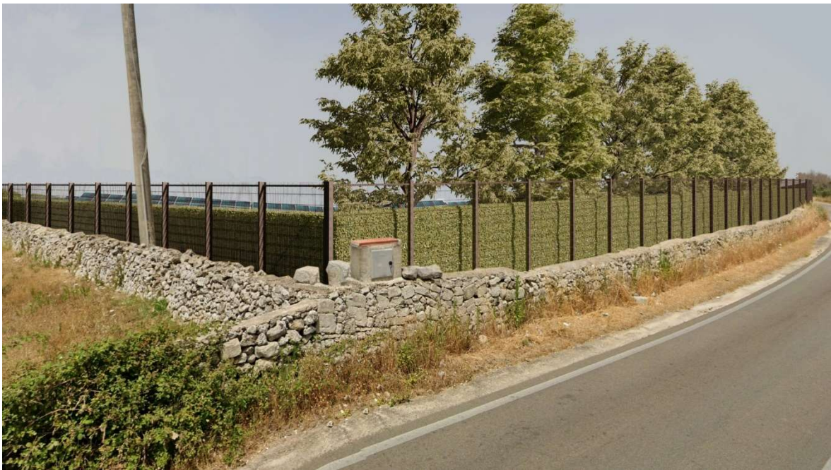
FOTO 1: Vista dalla SP147 in direzione NE prima (sopra) e dopo (sotto) la realizzazione dell'impianto e delle misure di mitigazione.
