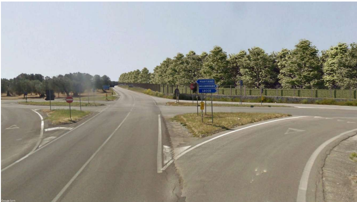
FOTO 3: Vista dall'incrocio tra la SP147 e la SP276 sulla sinistra e SP146 sulla destra prima della realizzazione dell'impianto (sopra) e dopo (sotto).
