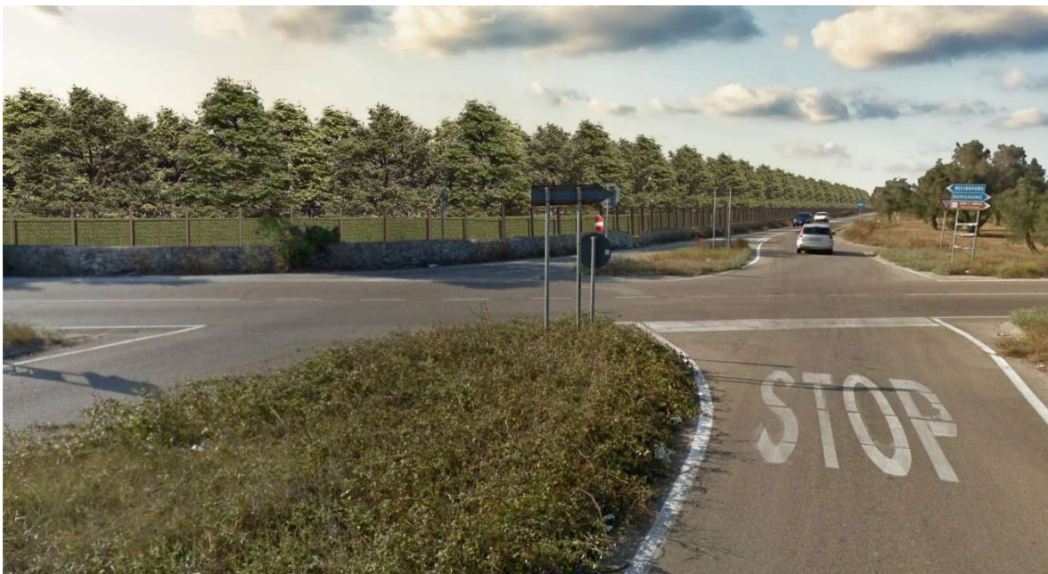
FOTO 2: Vista dall'incrocio tra la SP276 e la SP147 (di fronte la SP146) prima della realizzazione dell'impianto (sopra) e dopo (sotto).
