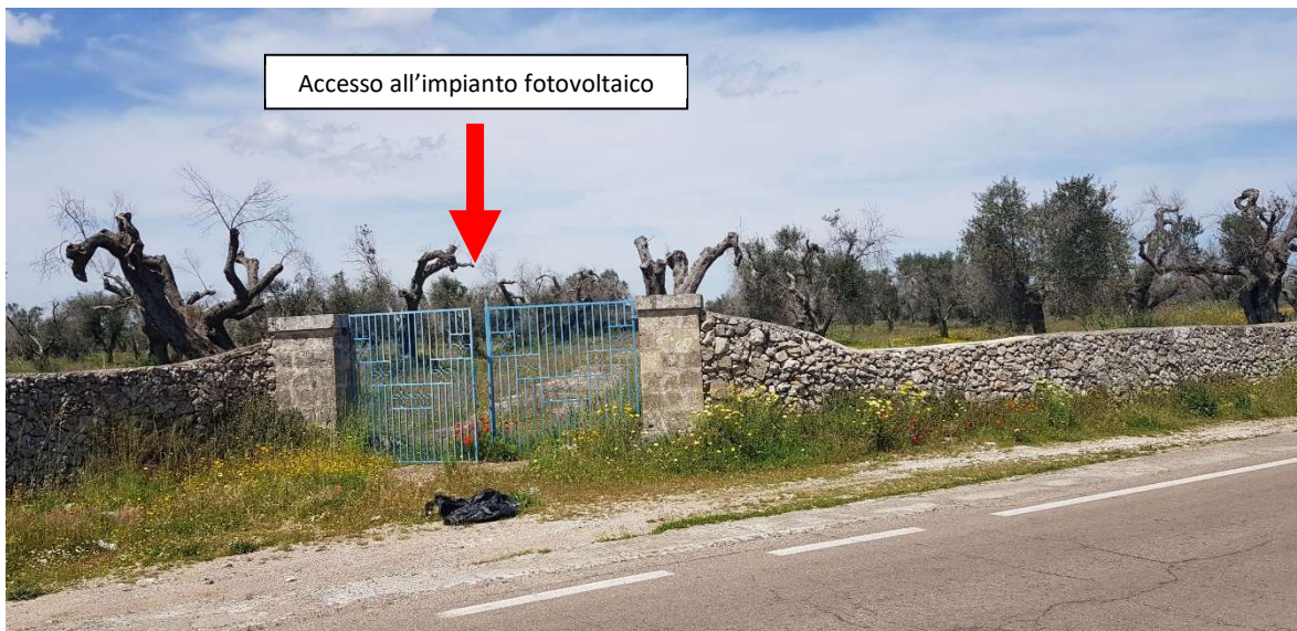
Fig. 2 – Panoramica verso l'ingresso del lotto in oggetto.
