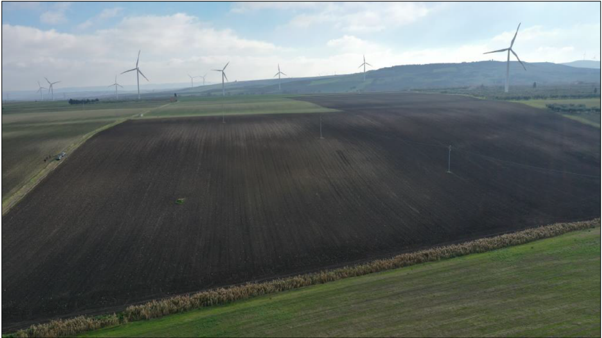
Figura 7 - Vista area da NORD dell'area d'impianto.
