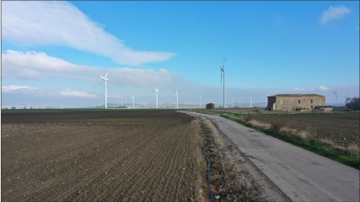
Figura 8 – Tracciato di connessione MT: tratto della SP103 interessato dall'attraversamento del cavidotto.
