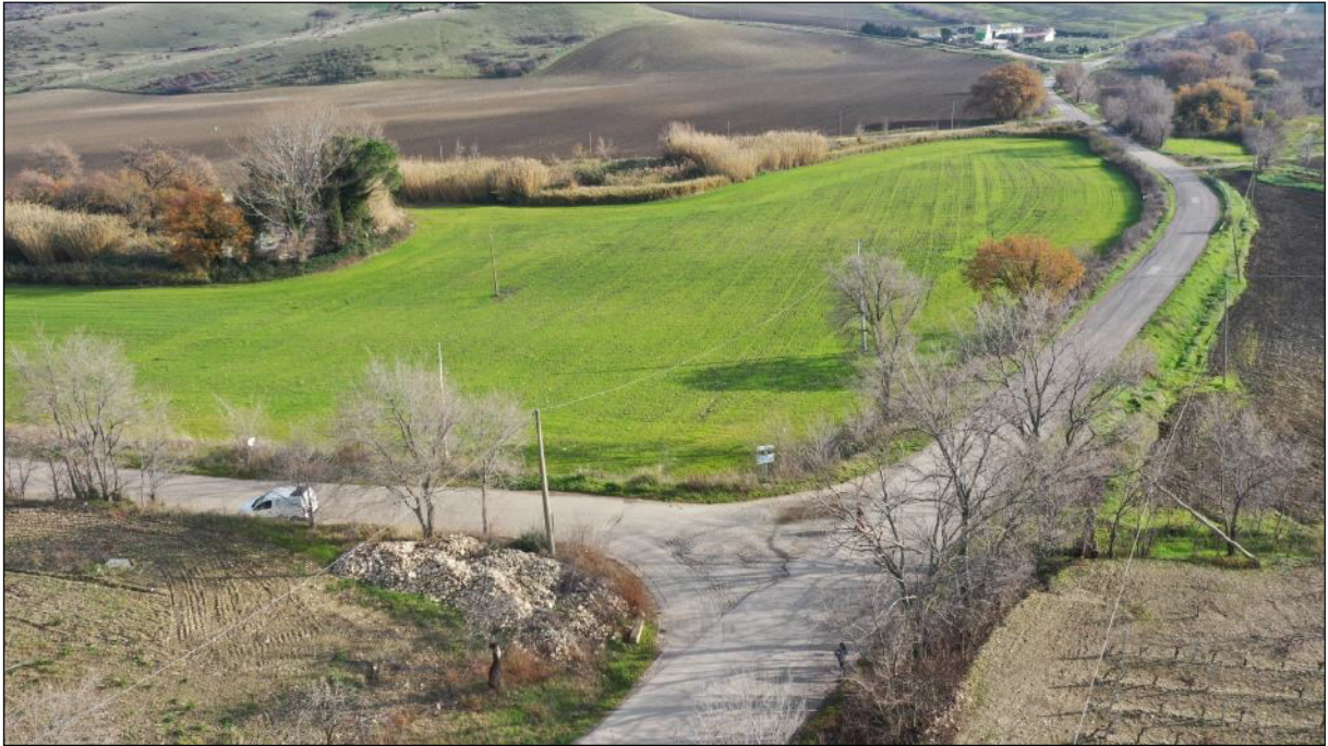
Figura 10 – Tracciato di connessione MT: svincolo tra la strada comunale e la SP102.
