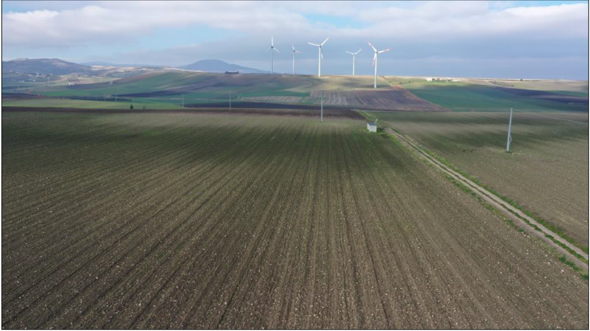
Figura 6 – Linea elettrica MT aerea e relativa cabina.
