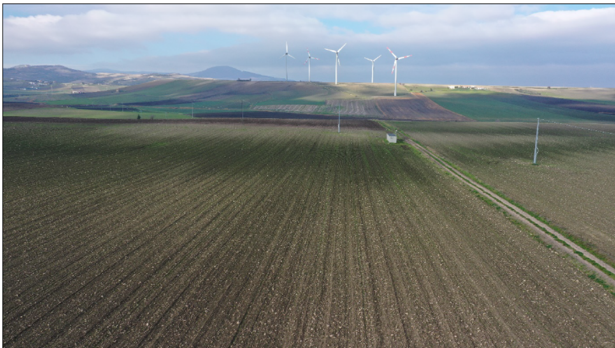
Figura 6 – Linea elettrica MT aerea e relativa cabina.
