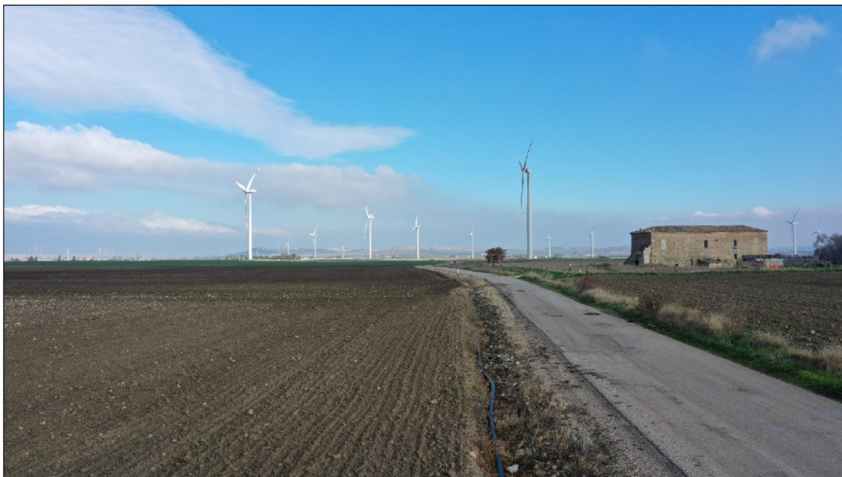
Figura 8 – Tracciato di connessione MT: tratto della SP103 interessato dall'attraversamento del cavidotto.
