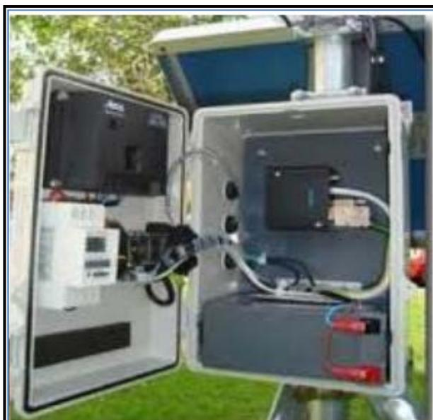
Unità di gestione dell'irrigazione con PLC, datalogger, modulo GSM, e moduli attuatori di comando della elettrovalvole.
