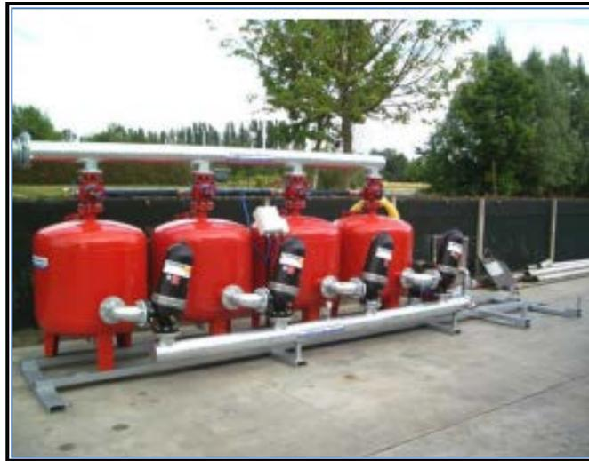
Stazione di filtrazione con filtri a graniglia e filtri a rete in parallelo
