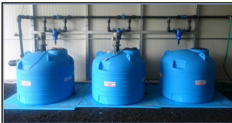
Parte di un impianto di fertirrigazione: Tuniche in linea di fertilizzanti liquidi e acido
