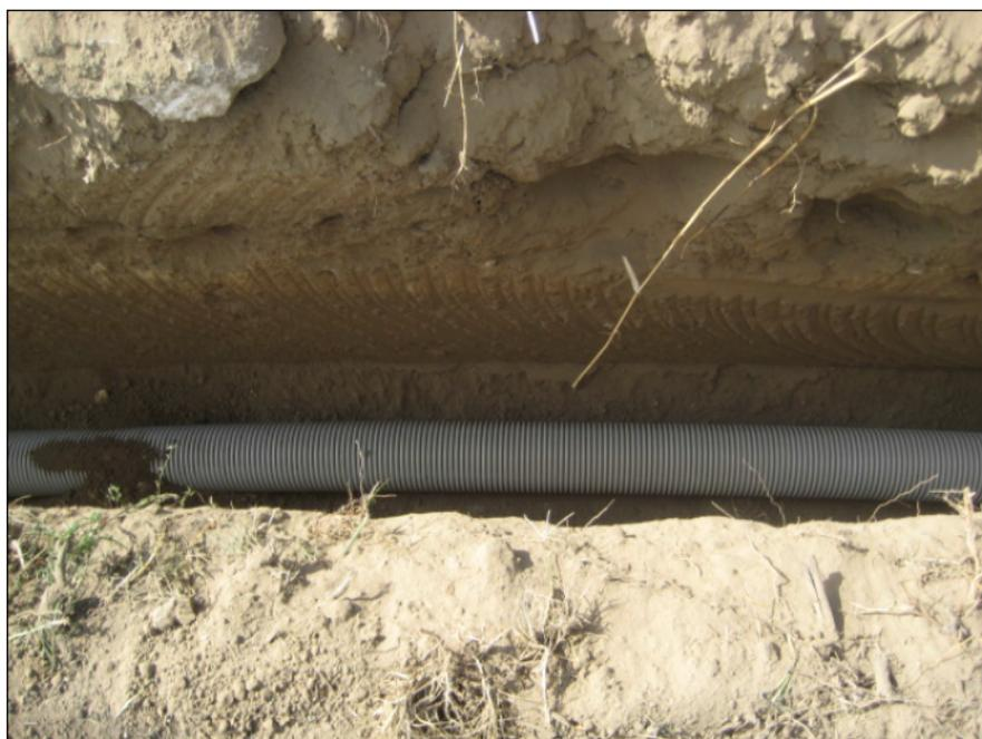
*Figura 12. - Tipologico scavo per cavidotto MT.*
