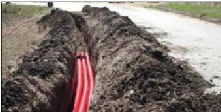
*Figura 11. - Tipologico scavo per cavidotto MT.*
