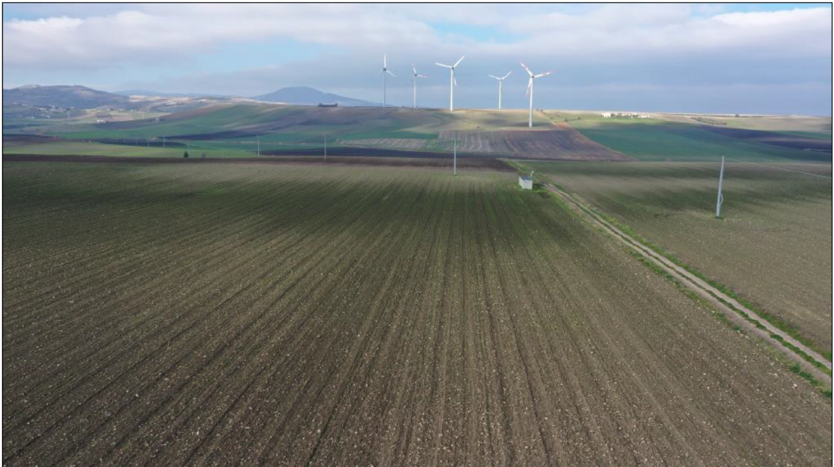
Figura 6 – Linea elettrica MT aerea e relativa cabina.
