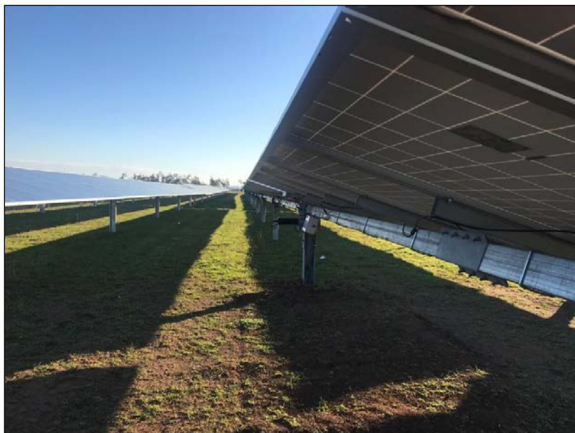
Esempio di installazione di un inseguitore SunHunter
