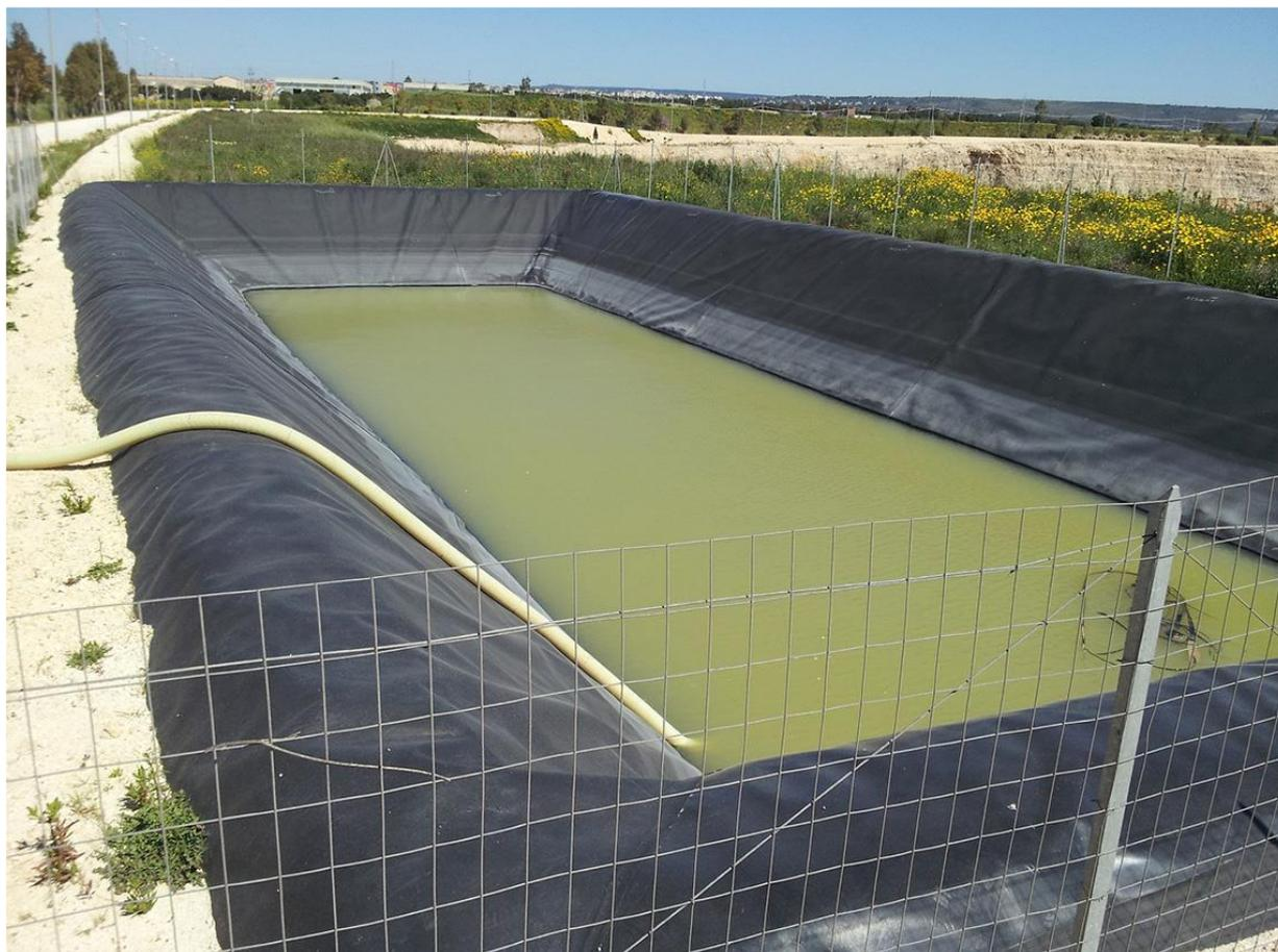
**Fig. 32 – Esempio di vasca raccolta acque piovane**
