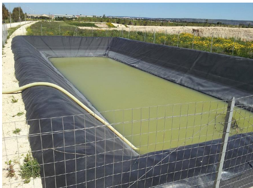
Fig. 4 – Esempio di vasca raccolta acque piovane
