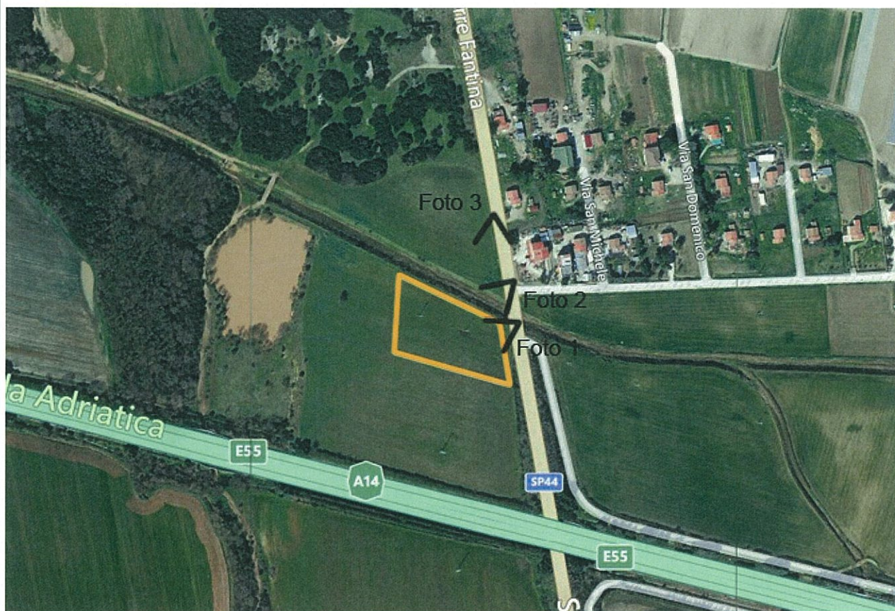
Vista aerea dell'AT12.
