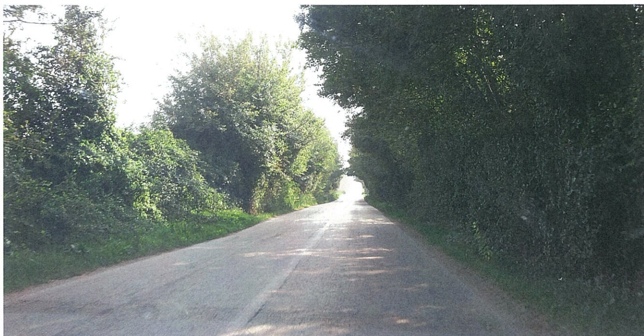
Strada Provinciale n.44
