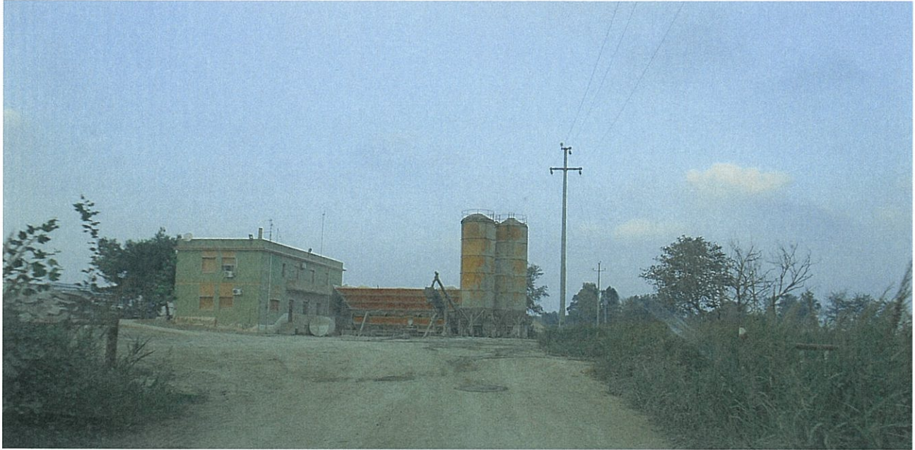
Impianto di betonaggio
