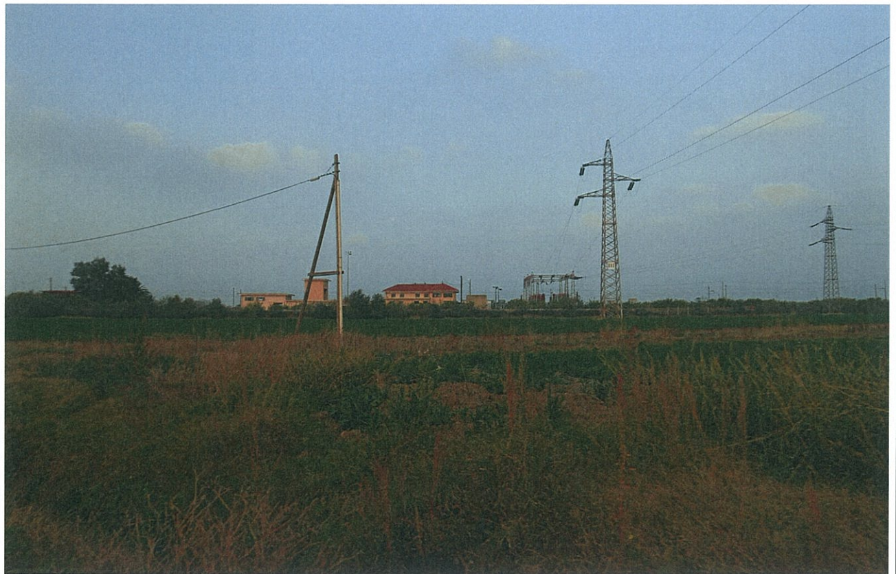
Stazione FS di Ripalta vecchia
