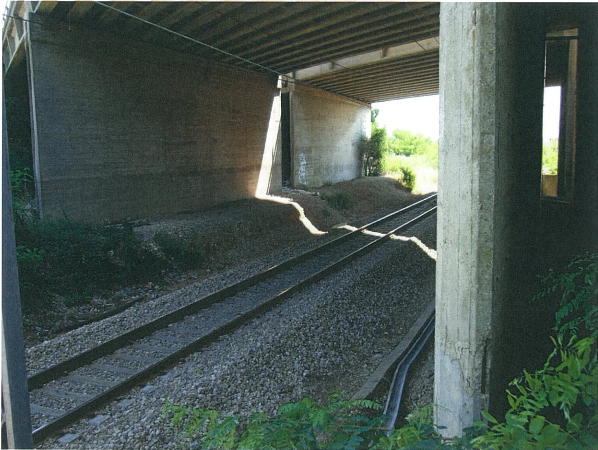
Foto 1 CVF autostrada A14
