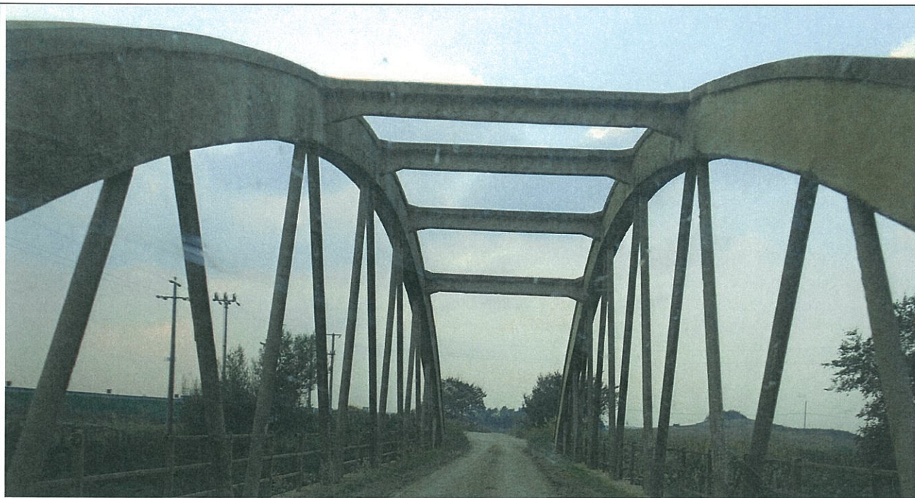
Ponte in ferro
