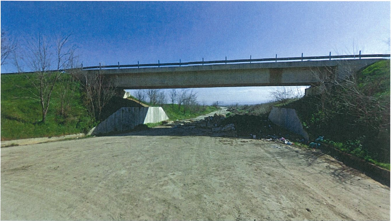
Foto 2 Strada Pede sub appenninica dalla SS 16 verso la SP 37
