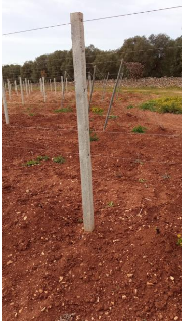
Foto 9 – Palo intermedio in cemento
