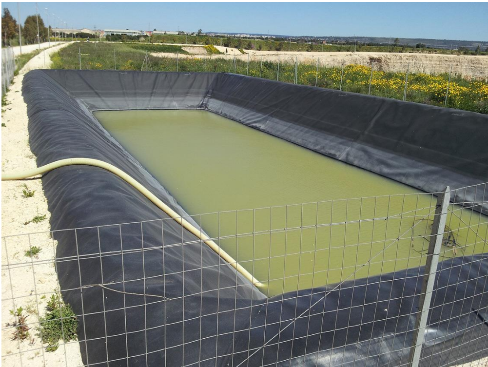
Foto 5 – Esempio di vasca raccolta acque piovane.
