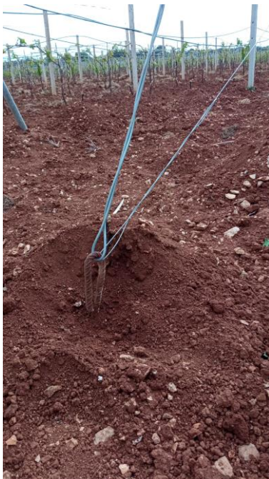
Foto 11 – Ancoraggio in ferro
