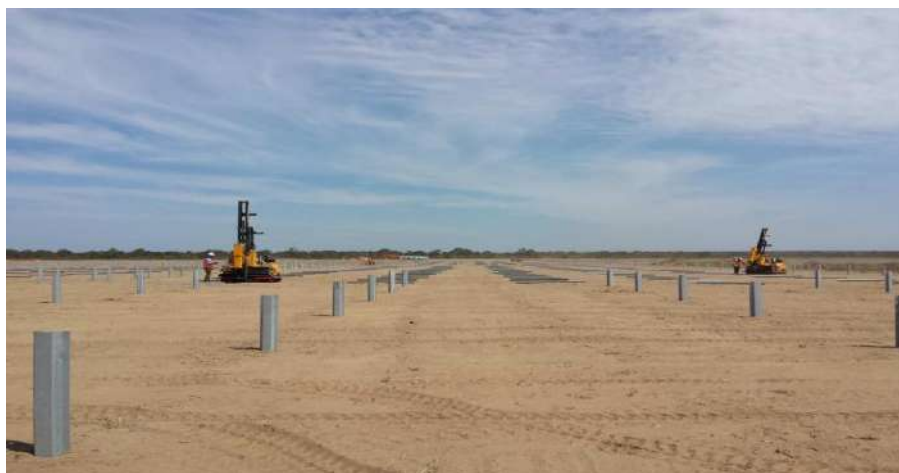
Figura 7 – Posa tipologica della struttura di sostegno del modulo fotovoltaico
