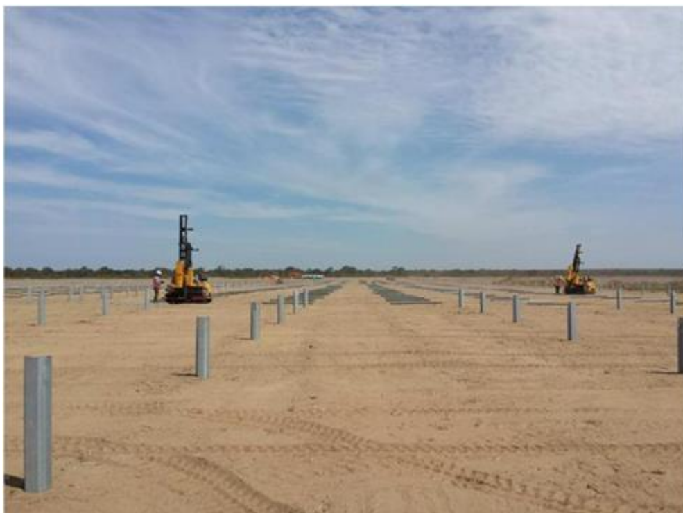
Figura 13 – Fase di infissione dei pali con profilo omega (fonte Convert)
